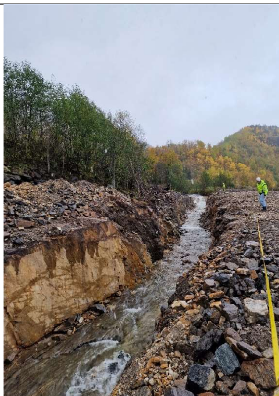
Bilde 2-2 , viser kanalen som ble bygget i 2023. En tilsvarende kanal vil bli bygget i ny og lenger omlegging høyere i terrenget. Kanalen på bildet er om lag 4 m bred og 2,2 m dyp.
