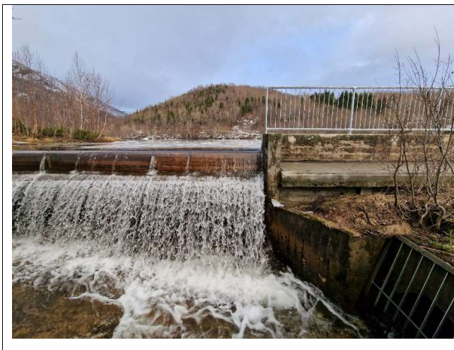
Bilde 3-1 , viser terskelen i Dammen
