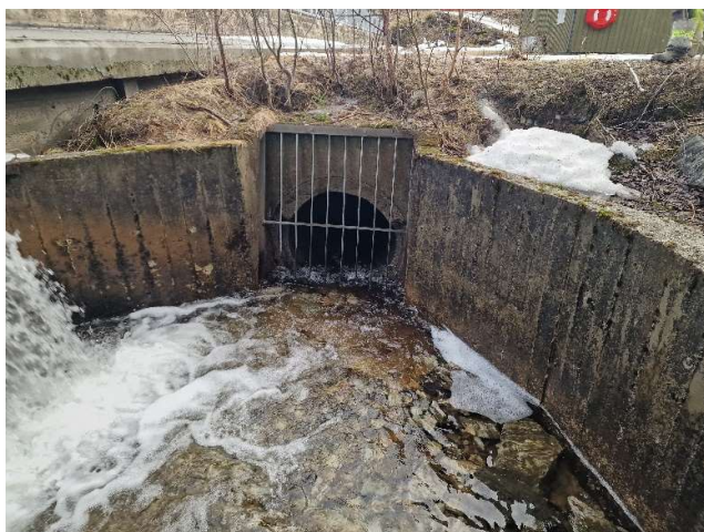
Bilde 3-3 , viser bekkeinntaket nedstrøms Dammen
