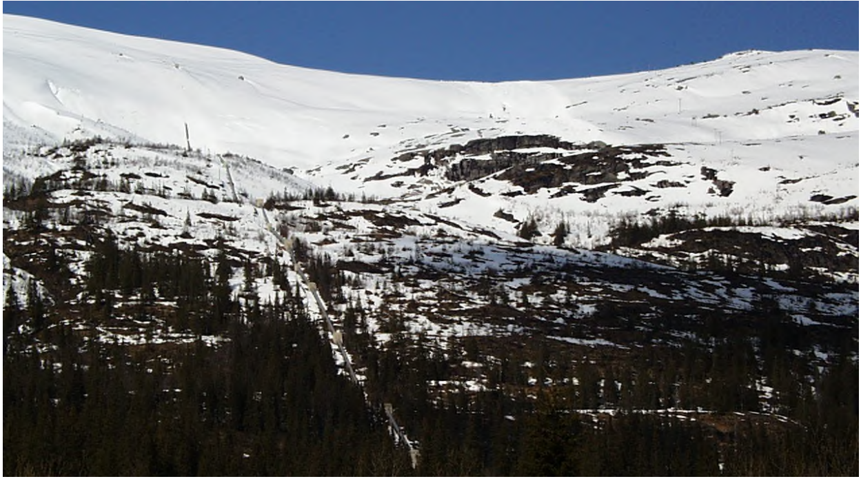
Figur 8: Dalsiden mellom Envatn og kraftstasjonen med rørgaten som går i dagen.
