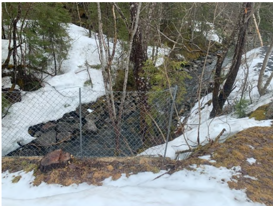
Figur 11: Avløpskanal fra Kraftverket.
