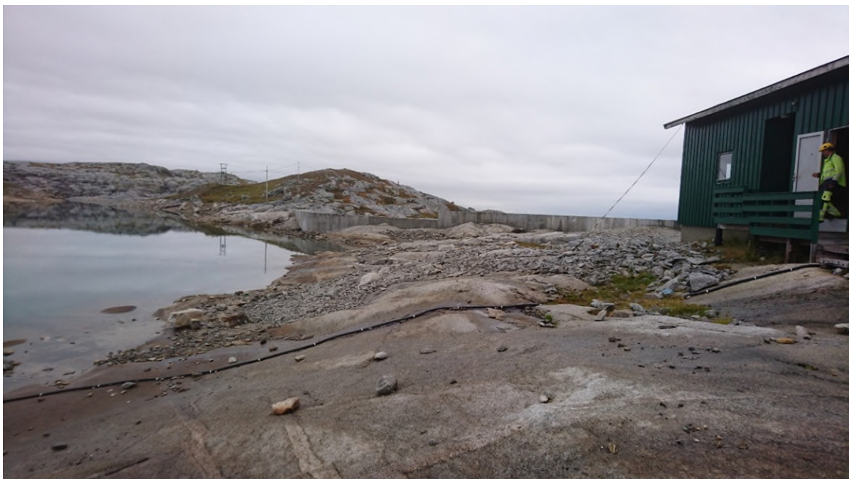
Figur 7: Dam og lukehus ved Envatn.
