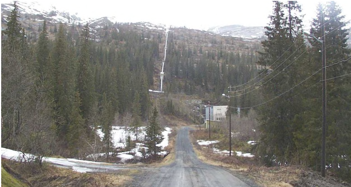
Figur 9: Området med kraftstasjon og vannvei i dagen.
