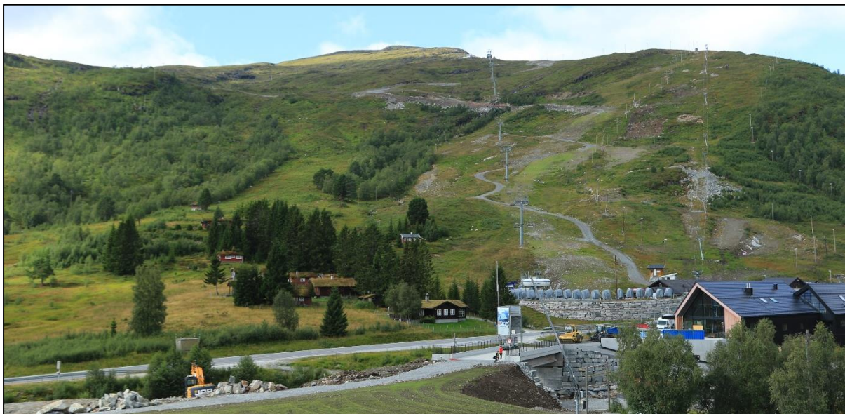
Figur 3-14. Løpet til Langedalselva går mellom grantrærne i bildet før det dreier mot høyre og følger nærmere stolheistraseen om lag midt i bildet. Til venstre for rekken av grantrær ligger bygningene innenfor hensynssonen for kulturmiljø. Foto: Pia N. Petersen.
