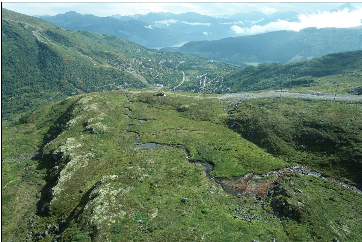
Figur 3-8. Langedalselva i området som er planlagt demmet ned. Dronefoto: Strandafjellet skisenter.
