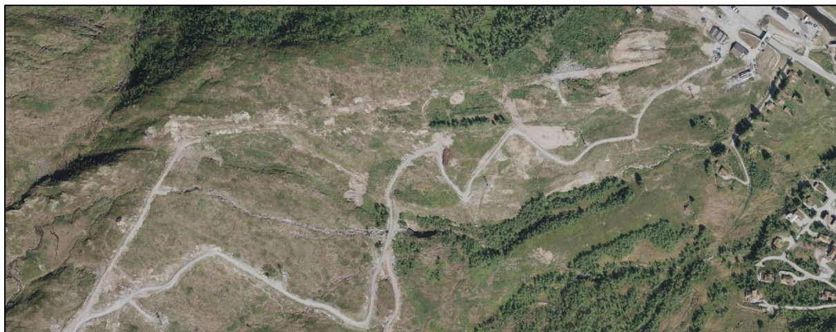
Figur 1-4. Langedalselva fra myrområdet som planlegges oppdemmet (t.v.) og ned til utløpet i Fursetelva (t.h.). Flytofoto er hentet fra www.norgeskart.no .
