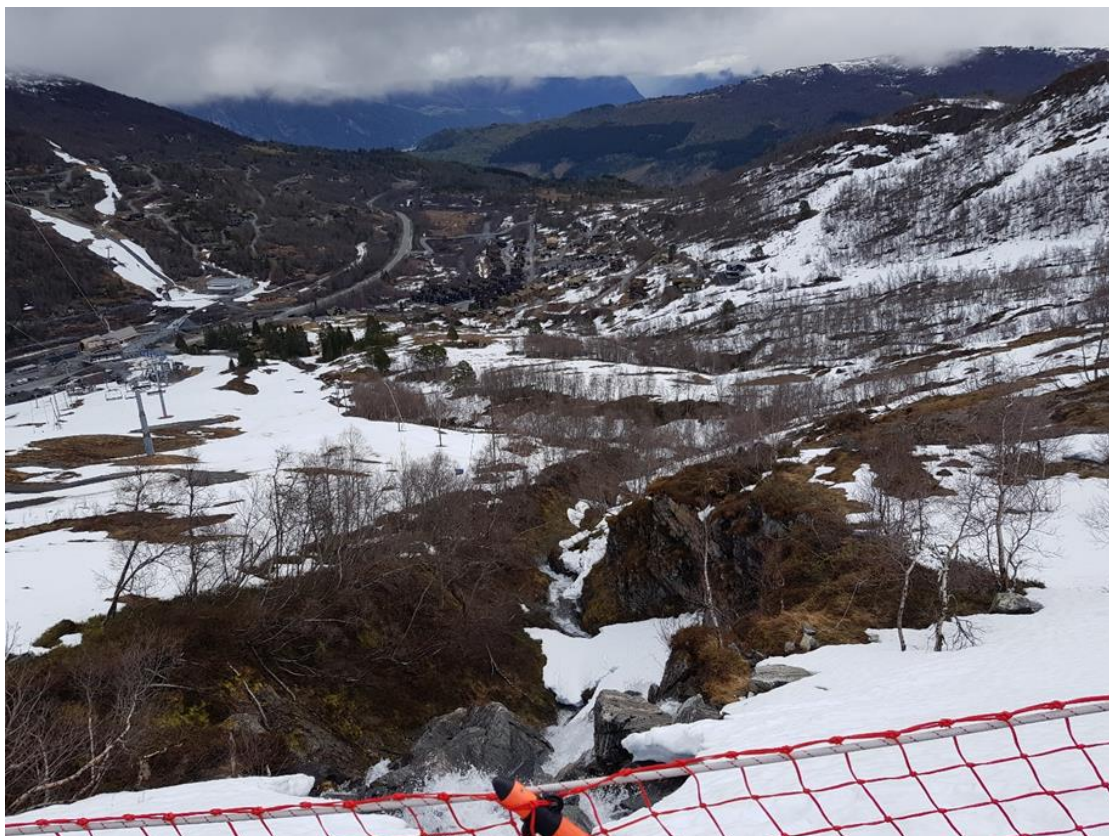
Foto fra anleggsveien og ned mot bekkekløfta i Langedalselva. Foto: Strandafjellet skisenter.
