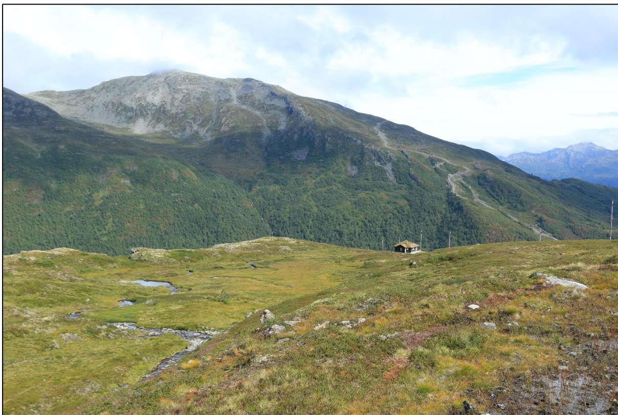
Damområdet sett oppstrøms. Foto: Pia N. Petersen (Multiconsult).
