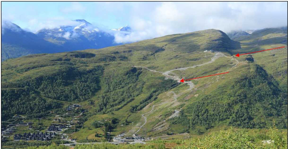
Langedalselva sett fra fjellsiden opp mot Roaldshornet på motsatt dalside. Planlagt damområde og topp av foss er vist med piler. Foto: Pia N. Petersen (Multiconsult).
