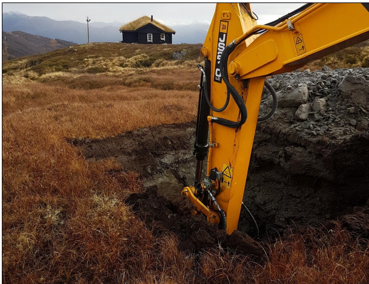
Figur 3-22. Strandafjellet skisenter's prøvegraving av myra oktober 2017 viste en gjennomsnittlig dybde på 3 meter. Under myrtorven var det uorganiske masser som ligger i haugen med oppgravde masser til høyre i bildet. Foto: Strandafjellet skisenter.
