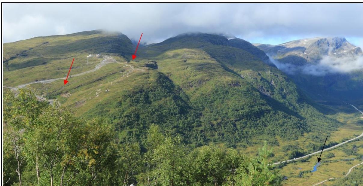
Figur 3-7. Oversiktsbilde som viser damsted (rød pil, øverst) og videre løp for Langedalselva (rød pil, nederst) samt Fursetelva (svart pil) oppstrøms samløpet med Langedalselva. Foto: Pia N. Petersen.
