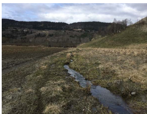
Figur C6: Ingen erosjon mot jernbanefylling.
