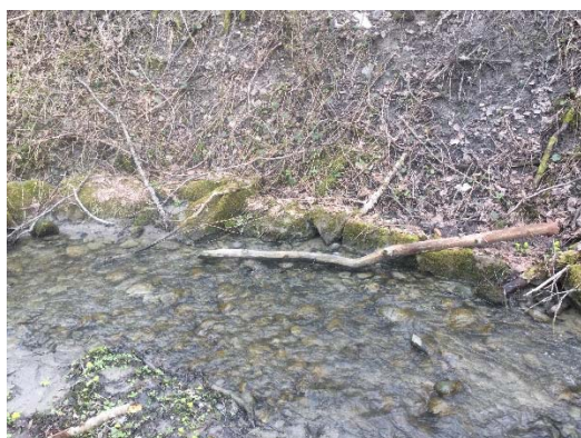
Figur B5: Forsøk på å sikre mot erosjon.
