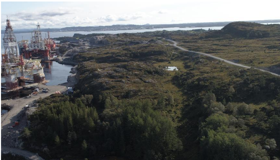
Figur 2. Oversiktsbilde over tiltaksområdet med dam og magasinområdet midt i bildet (foto: Magne Hope AS)
