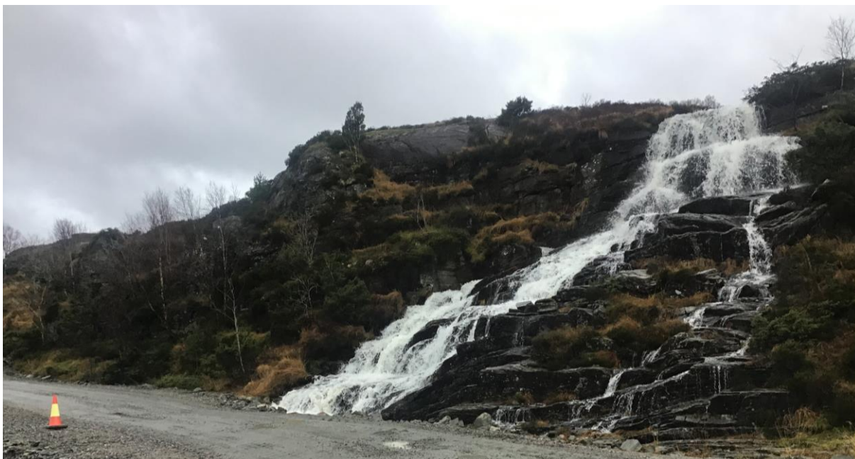
Figur 23. Bilde viser utløpsbekk før den krysser ny anleggsvei i kulvert (Foto: Multiconsult).
