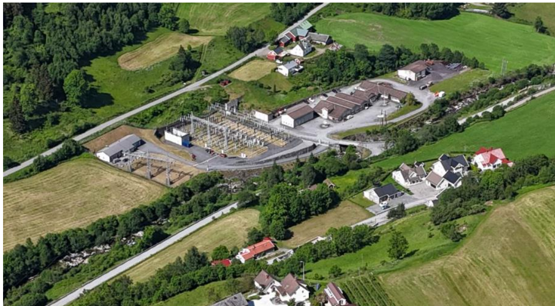
Figur 13 Dronebilde av Hove transformatorstasjon, Sweco, 2024
