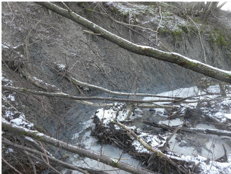
Bilde 6: Tydelige spor av ras i bekkesiden
