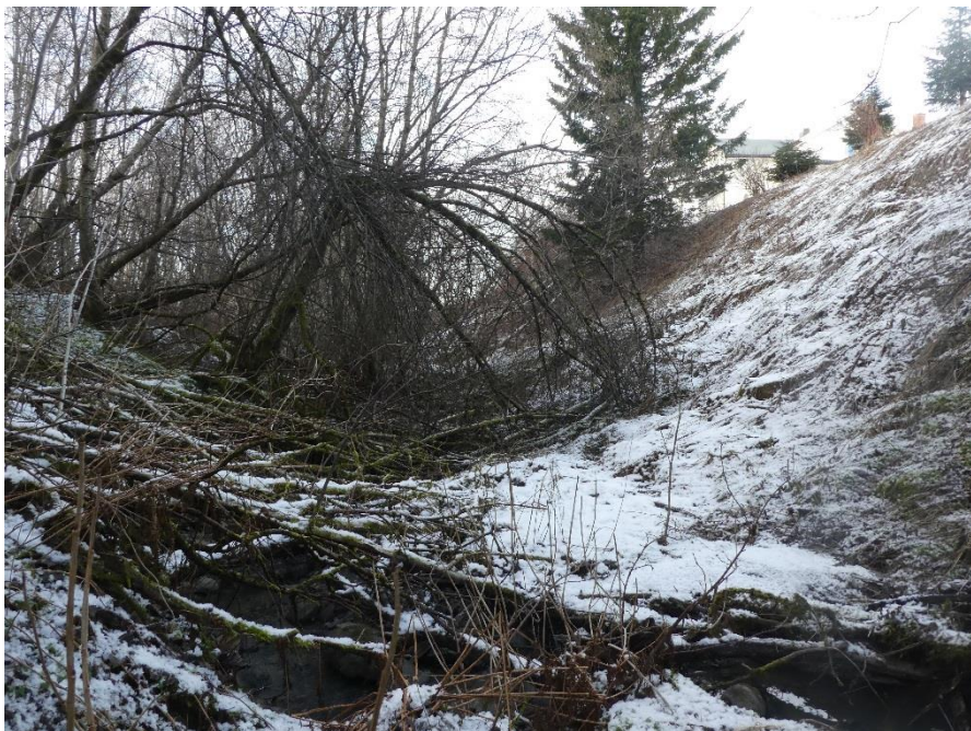
Bilde 4: Utglidninger og ras har ført til at vegetasjon har veltet og falt ut i bekken. Legg merke til tomannsboligen på toppen av den bratte skråningen til høyre i bildet.
