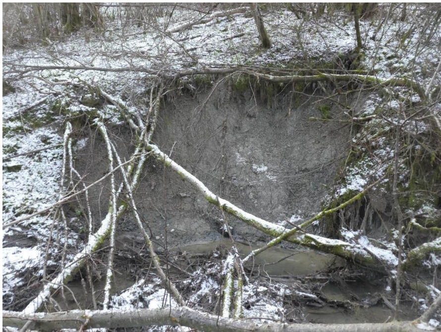
Bilde 3: Rasgrop i bratt skråning.
