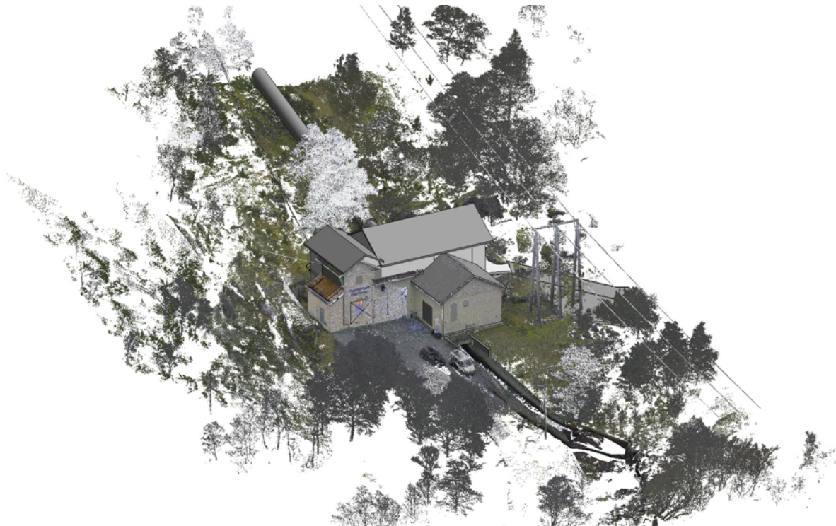
Figur 1: Ved konsesjon til alternativ II brukes eksisterende tilkomst, det nye kraftverksbygget vil bli bygd sammen med den eksisterende bygningsmassen. (Søkers justerte plan for utvidelse av Tveitafoss kraftstasjon, dok #26).
