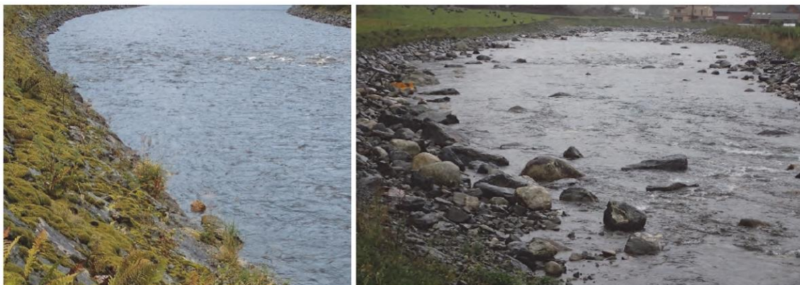
Figur 7. Eksempel på at klassisk flomsikring og homogent elvemiljø (til venstre) kan modifieres til et bedre og variert habitat for fisk (til høyre), samtidig som flomsikringen opprettholdes.
