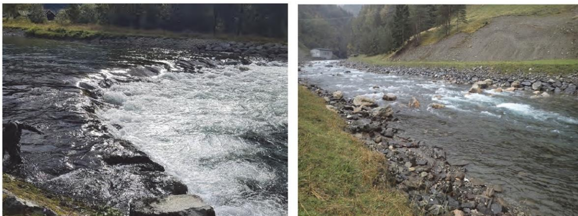
Figur 6. Eksempel på en klassisk syvdeterskel (til venstre), og et alternativt tiltak ved å etablere stor og langsgående variasjon langs elvebreddene ved bruk av store steiner (til høyre).
