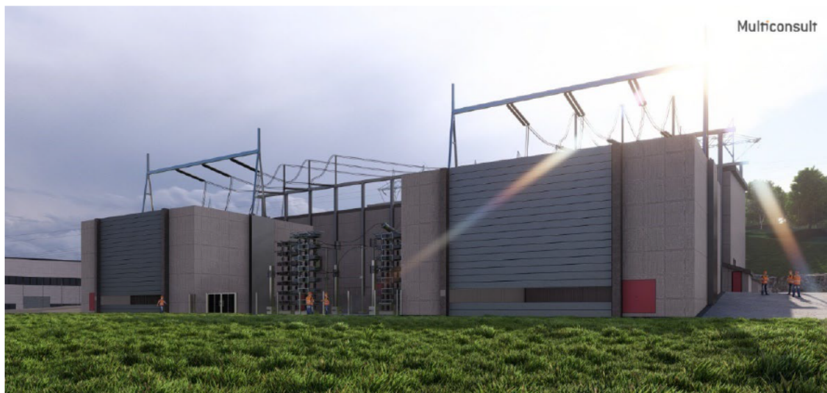
Figur 7: GIS-bygg, kondensatorbatteri og transformatorsjakter i Humleberget transformatorstasjon.
