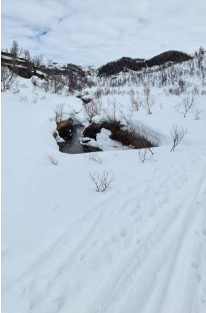
Overføringskanal frå Breisete. Teke i elvesvingen nedom «fossen» frå sør-vest mot Lomatjørn.
