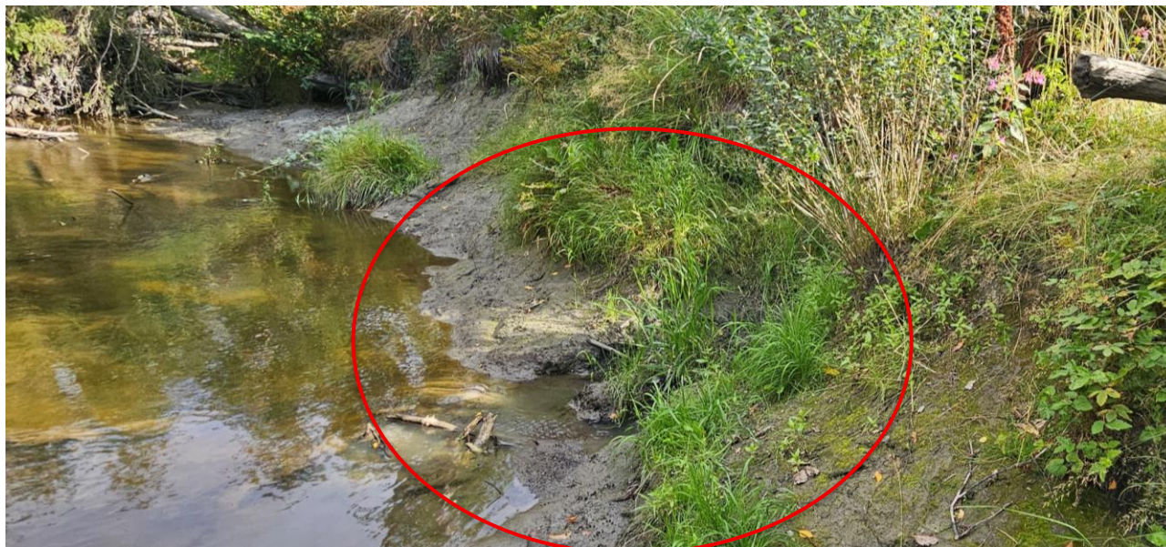
Figur 5-3 Utløpet til Gjermåa er knapt synlig i vegetasjonen.
