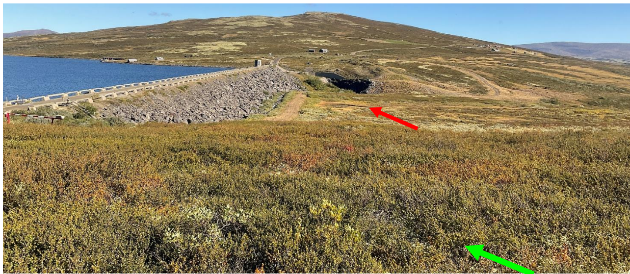
Figur 3-1 Nedstrøms dam Fundin «M10»: Tørre fattige lyng- og krattområder egnet for uttak av vegetasjonsmatter i forgrunn (grønn pil). Fuktigere områder, mindre egnet for uttak i bakgrunn (rød pil).
