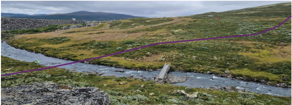
Figur 3-25. Kubrua ses midt i bildet. permanent vei er markert med lilla.
