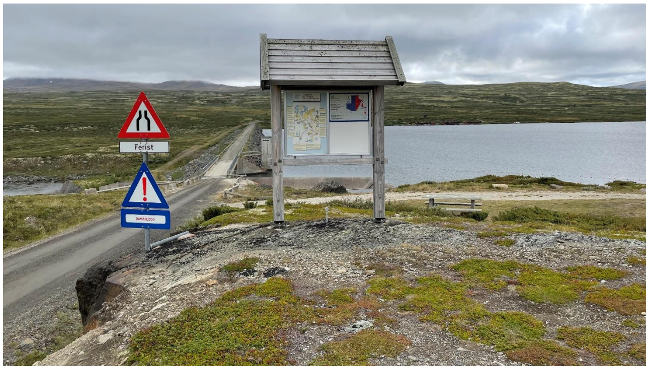
Figur 4-4 Dagens skilt står oppå en fjellskjæring, og er vanskelig tilgjengelig fra bilveien og for personer med nedsatt funksjonsevne.
