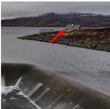
Figur 3-10 Dagens aggregathus som planlegges revet.
