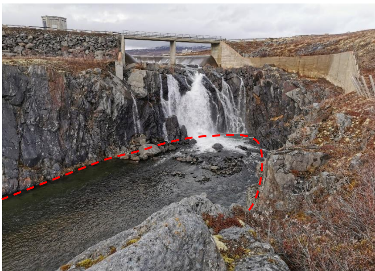
Figur 3-31 Riggområde 3 og mot venstre i bildet. Det går normalt ikke overløp på dammen.
