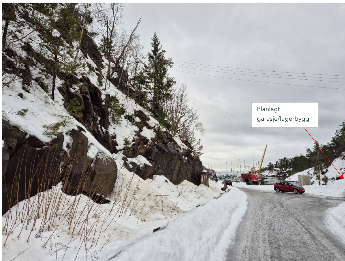
Figur 5: Foto tatt mot nord. Skråningen opp mot Hurumveien til venstre i bildet.
