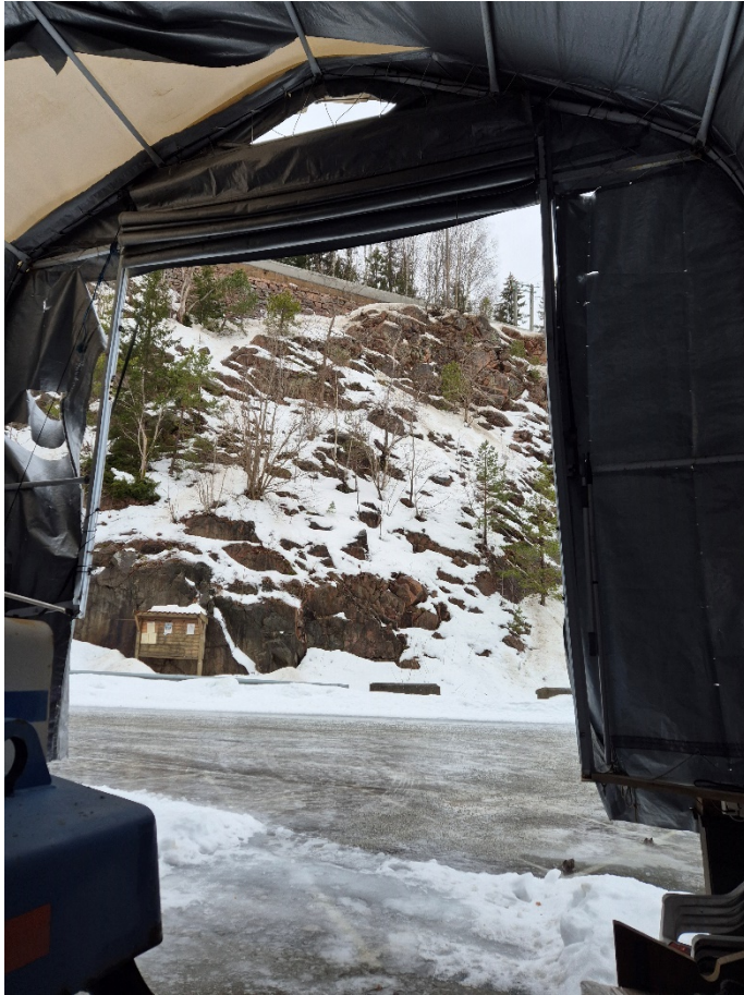
Figur 4: Foto fra inne i eksisterende teltgarasje, der det er planlagt oppføring av ny garasje/lagerbygg). Skråningen opp mot Hurumveien vises. Middels til tett oppsprekking i granitt.
