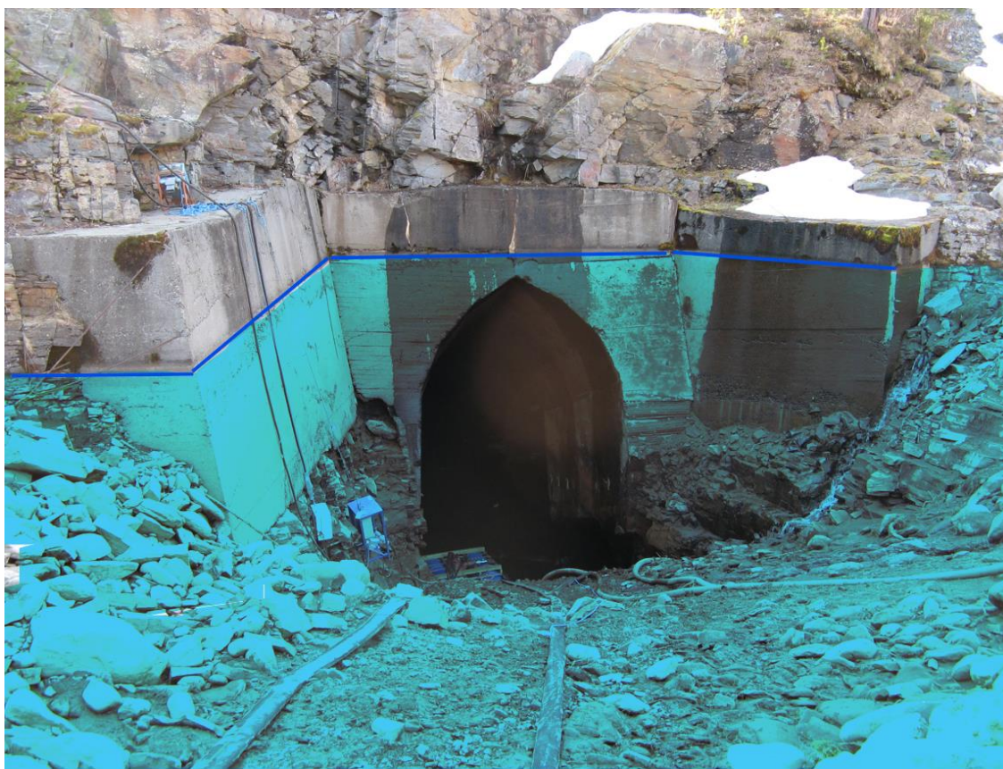
Figur 5 Bildet er fra tidligere arbeid som medførte behov for tømning av tunnel og tunnelutløp. Det blå området viser hvor vannspeilet står til vanlig. Som det vises på bildet så er det en betydelig høydeforskjell.
