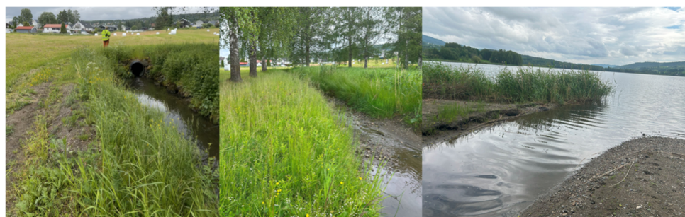
Figur 5 Situasjonsfoto fra eksisterende åpen strekning ned mot Jarenvannet
