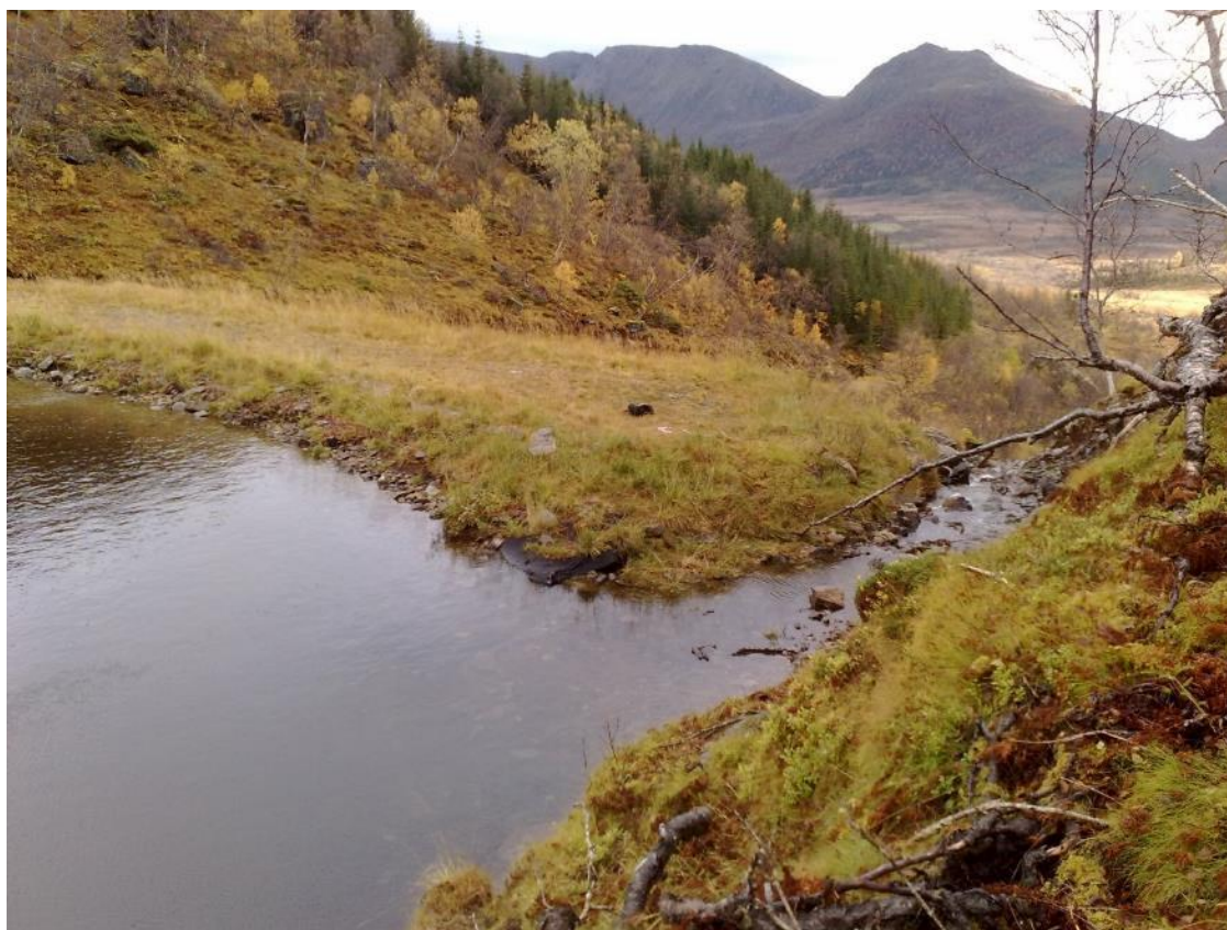
Bilde av dam ved utløp nedover( bilde NVE)
