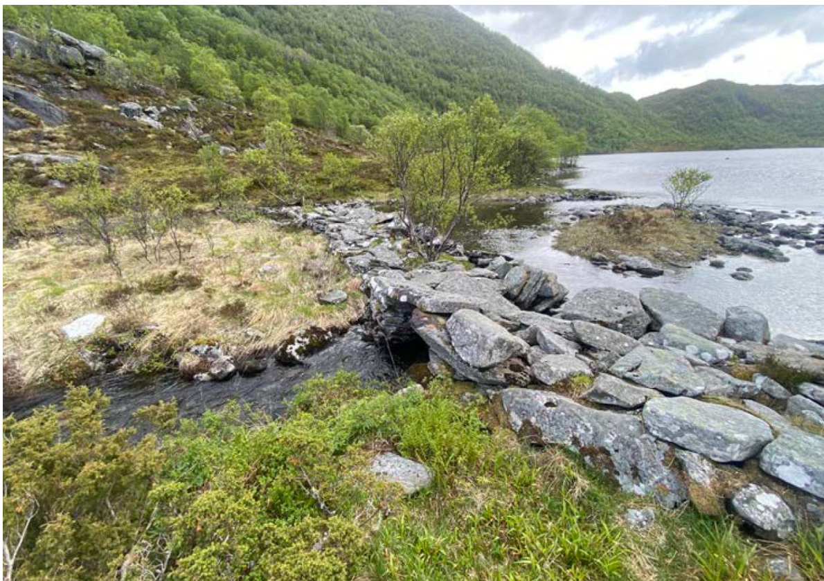
Figur 16 Steinmur og steinbru ved utløpet til Berstadelva (Foto: Rådgivende Biologer AS).
