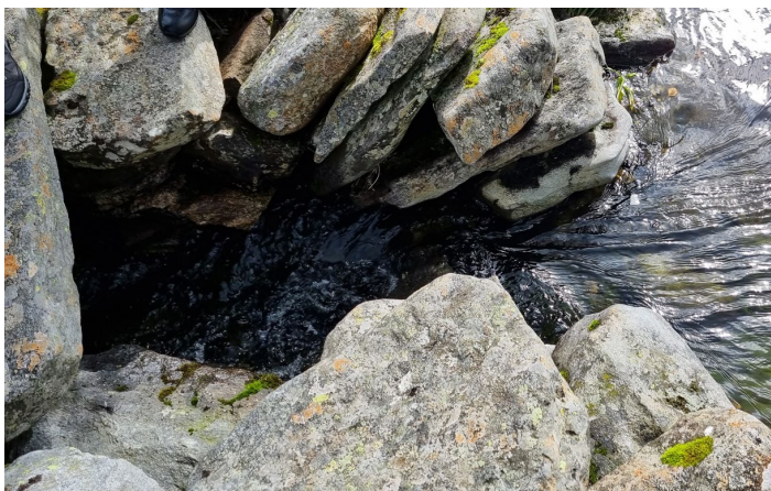
Figur 17 Ved steinbrua, opning i steinmuren der treluka var monterert (Foto: Nordplan).
