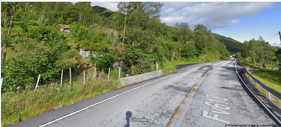
Figur 13 FV 618 ved elvekryssinga, to kvernhus ovanfor vegen (Google Maps, 2023).
