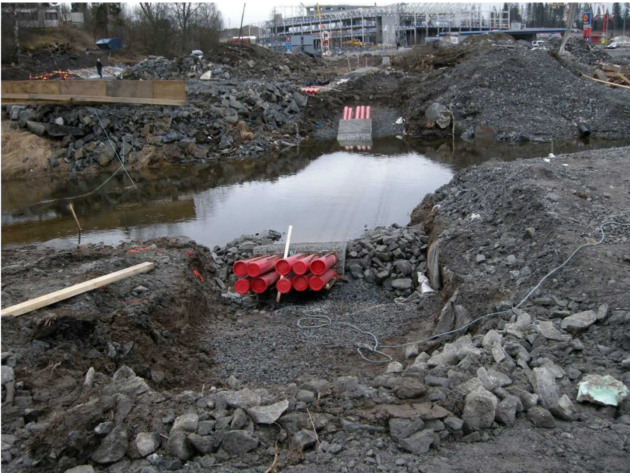
Figur 9. Bilde av lignende betongkasse og krysning av bekk.
