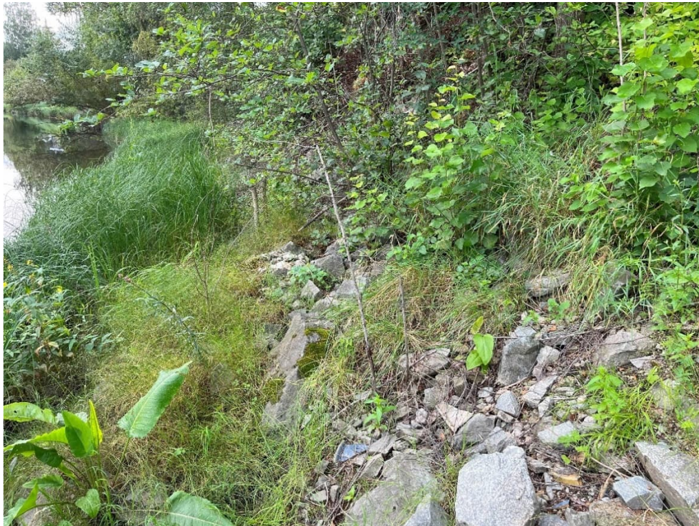
Figur 16: Langs elvekanten ved Vestfosselva ble det observert stein i forskjellige størrelser.
