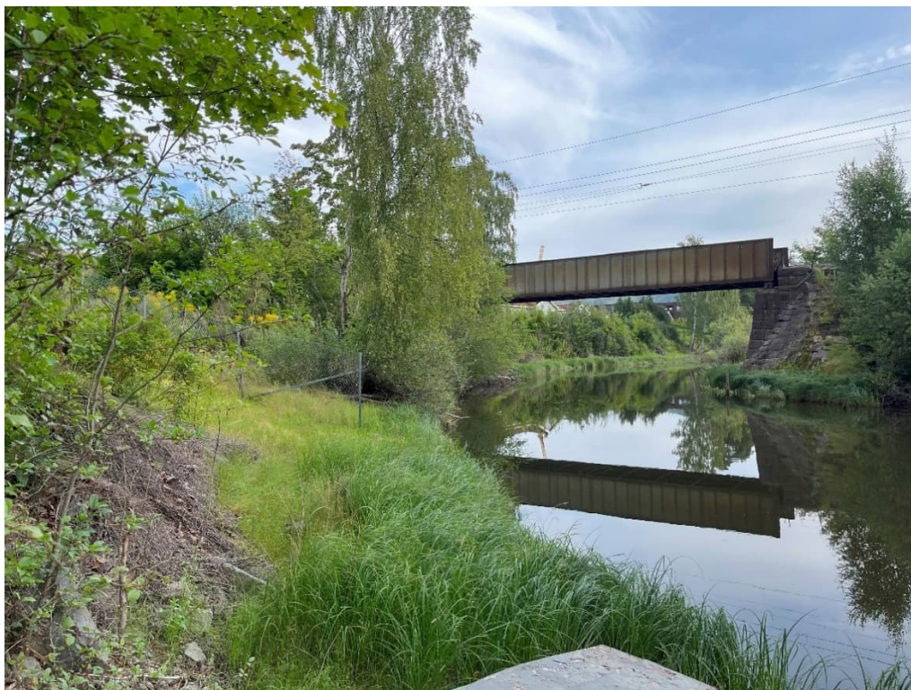
Figur 15: Bildet er sett fra elvekanten ved skråningen ned mot Vestfosselva mot øst.
