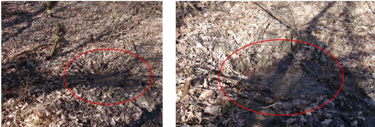
Figur 4.9: Oppkom, i form av bløtt parti med siltholdig grunn, avdekket ved befaring 15.03.2023.
