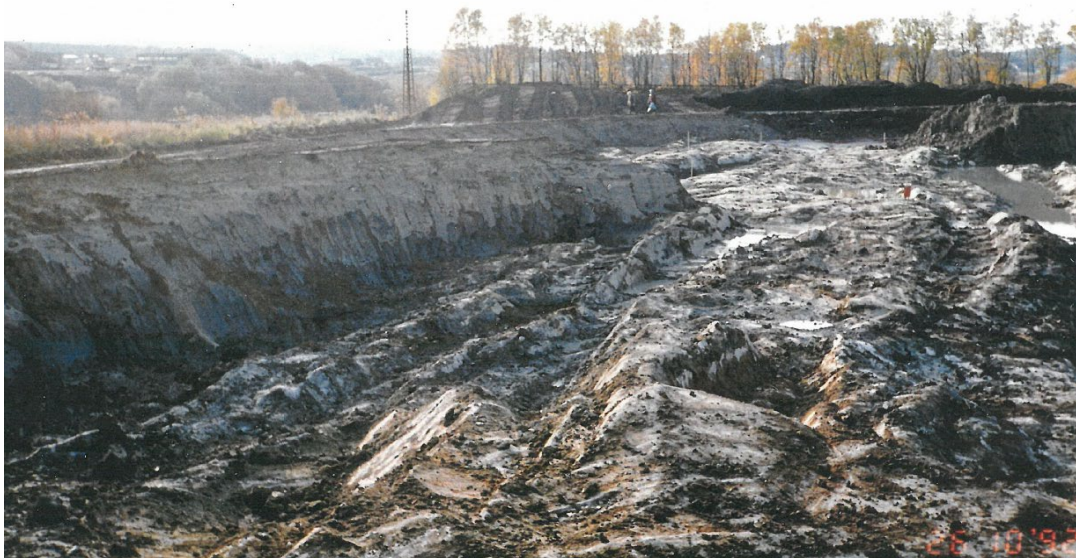
Figur 4.13: Rensket berg fra byggingen av renseanlegg. Foto: Noteby, 26.10.1992.
