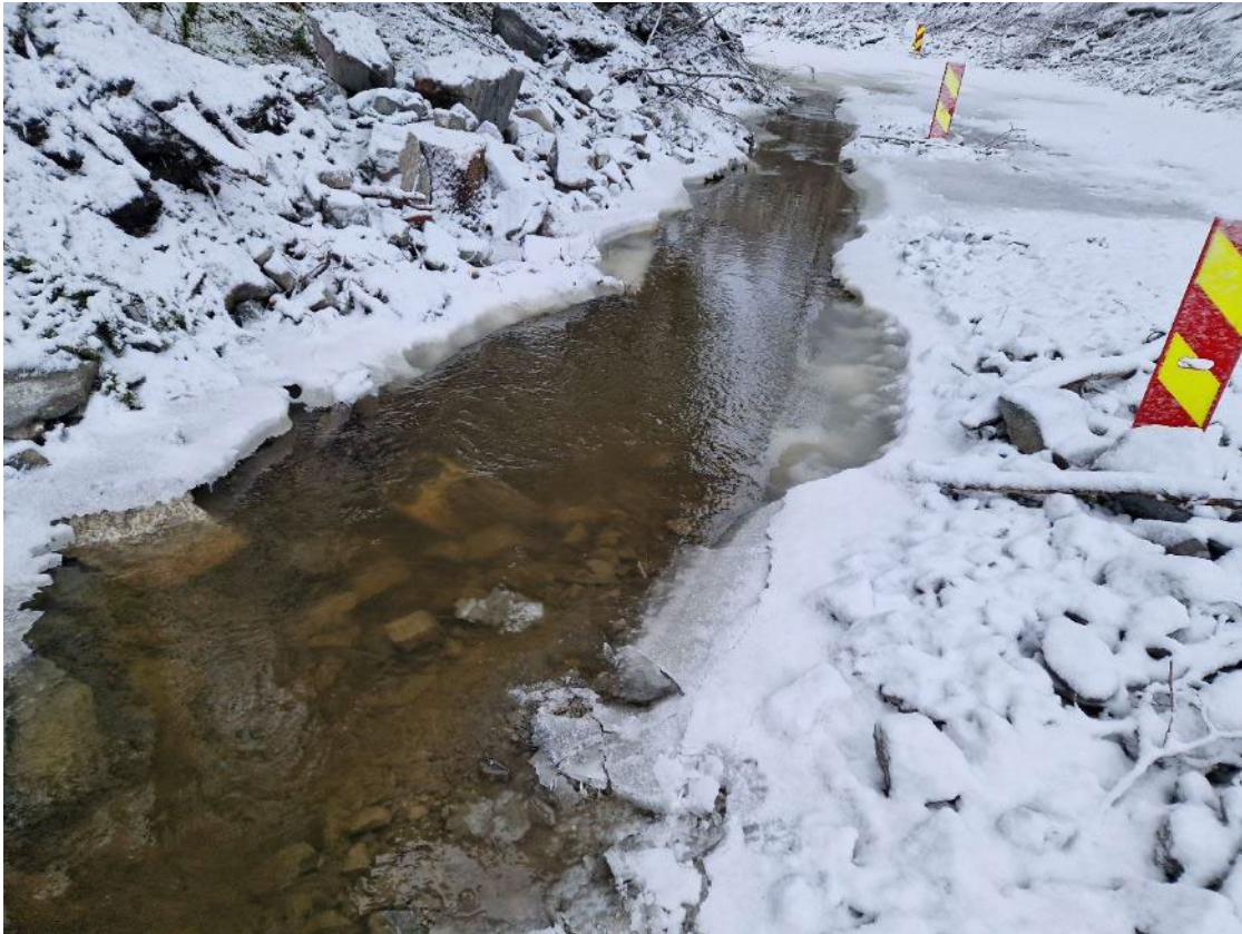
Figur 48 Midlertidig bekkeløp ved siden av anleggsvei
