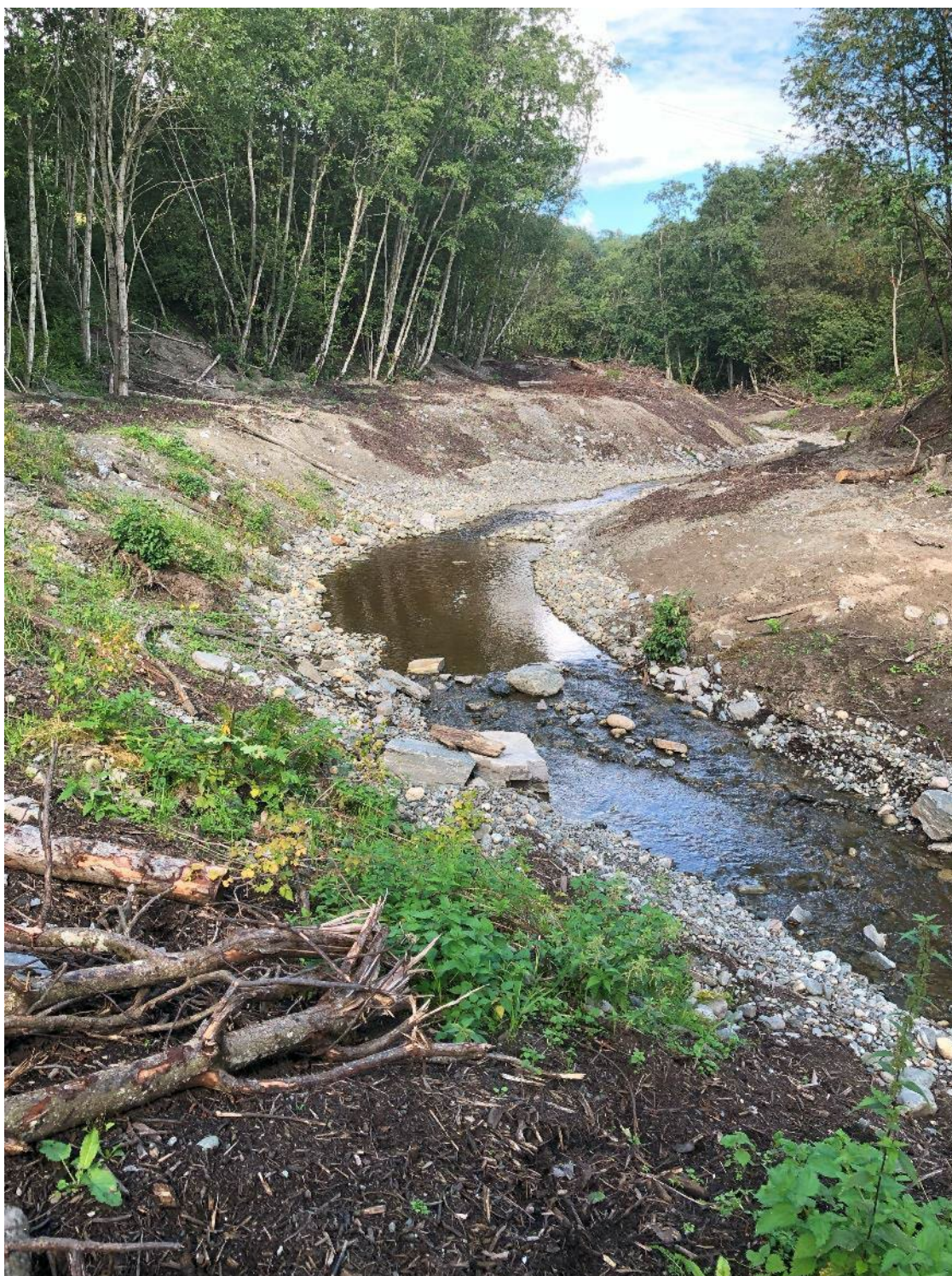
Figur 94 Erosjonssikring og motfylling, bilde tatt i retning oppstrøms
