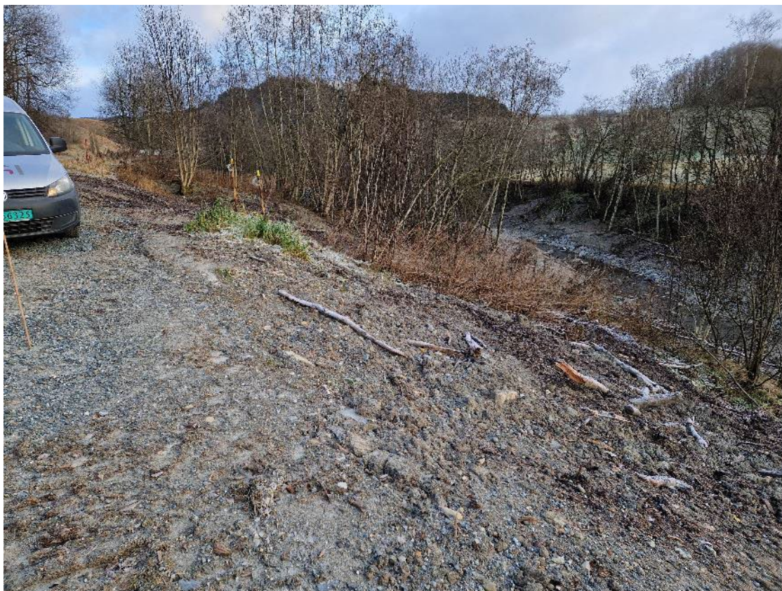
Figur 122 Området ved skredhendelsen, bilde av motfylling og erosjonssikring
