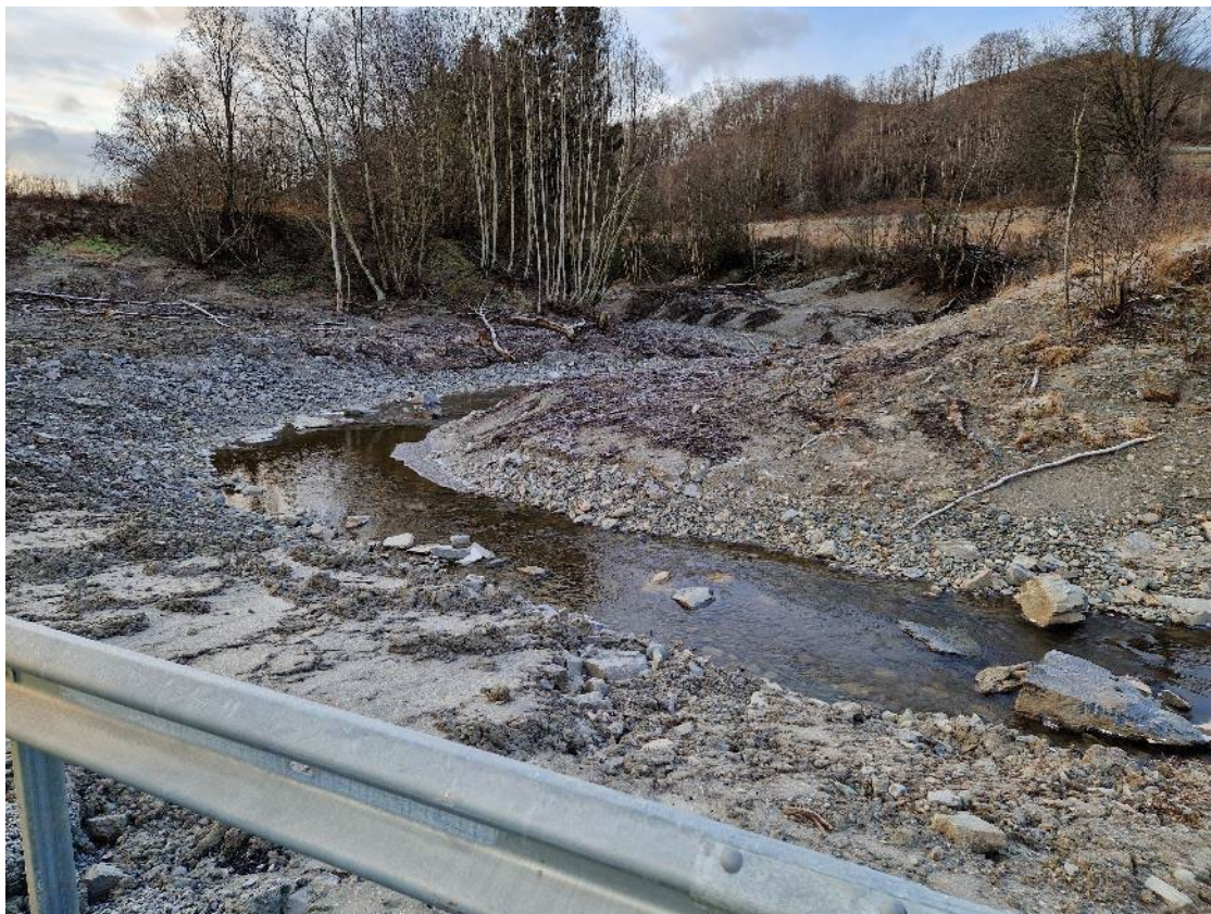
Figur 120 Området av tiltaket ve av/påkjøringen til anleggsveien
