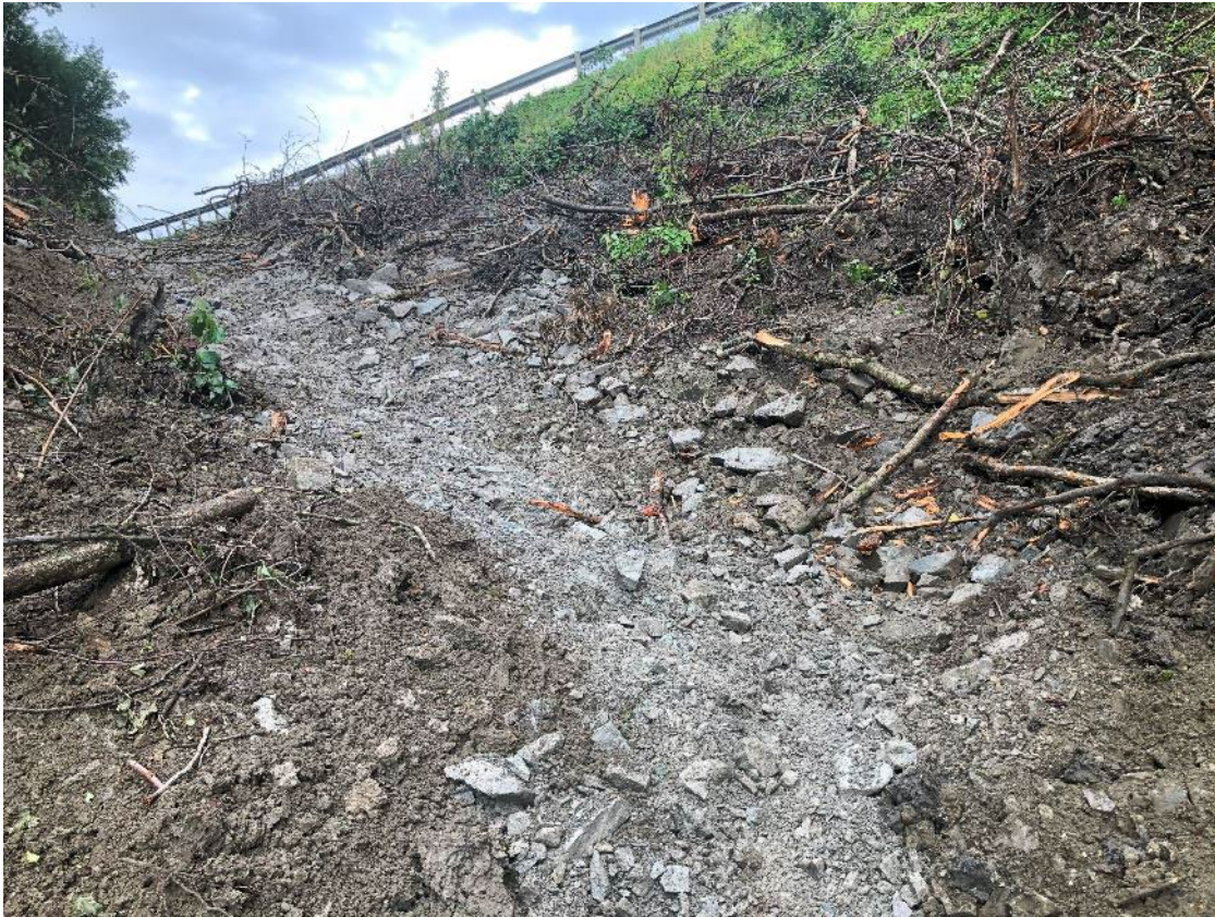
Figur 114 Erosjonssikret sideravine
