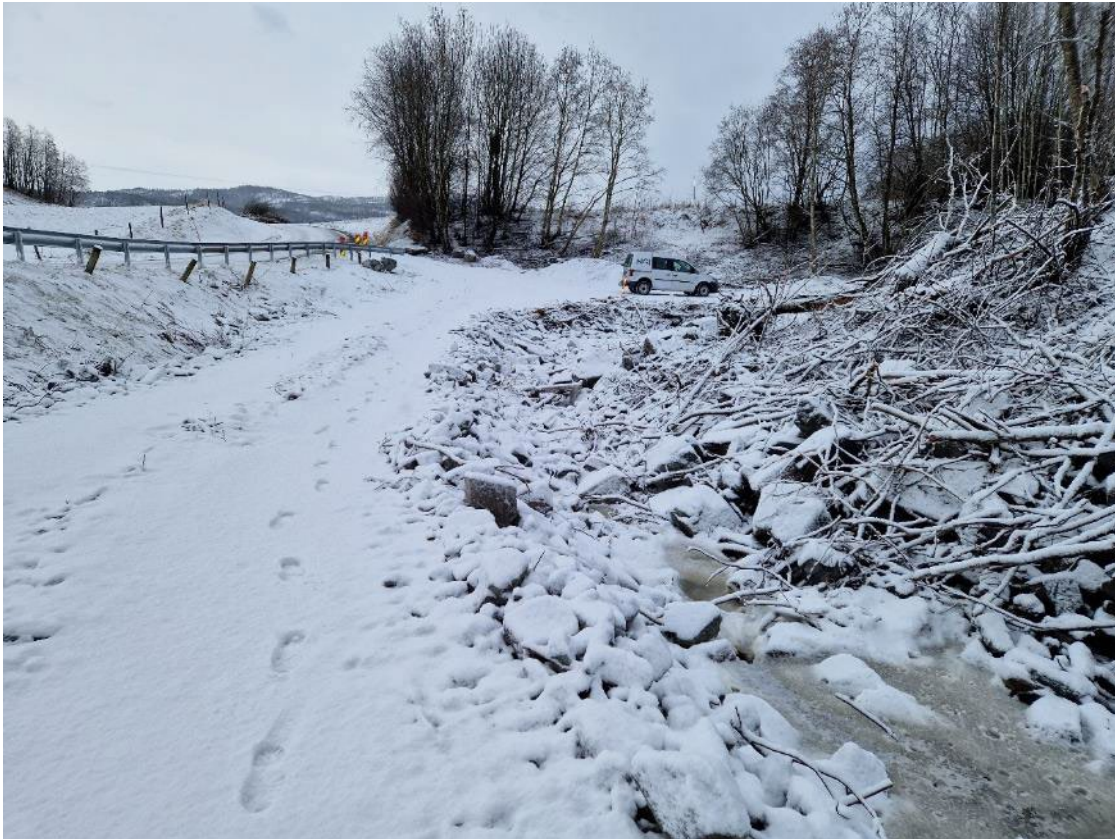
Figur 38 Bilde tatt i retning nedstrøms, ved av-/påkørsel anleggsvei
