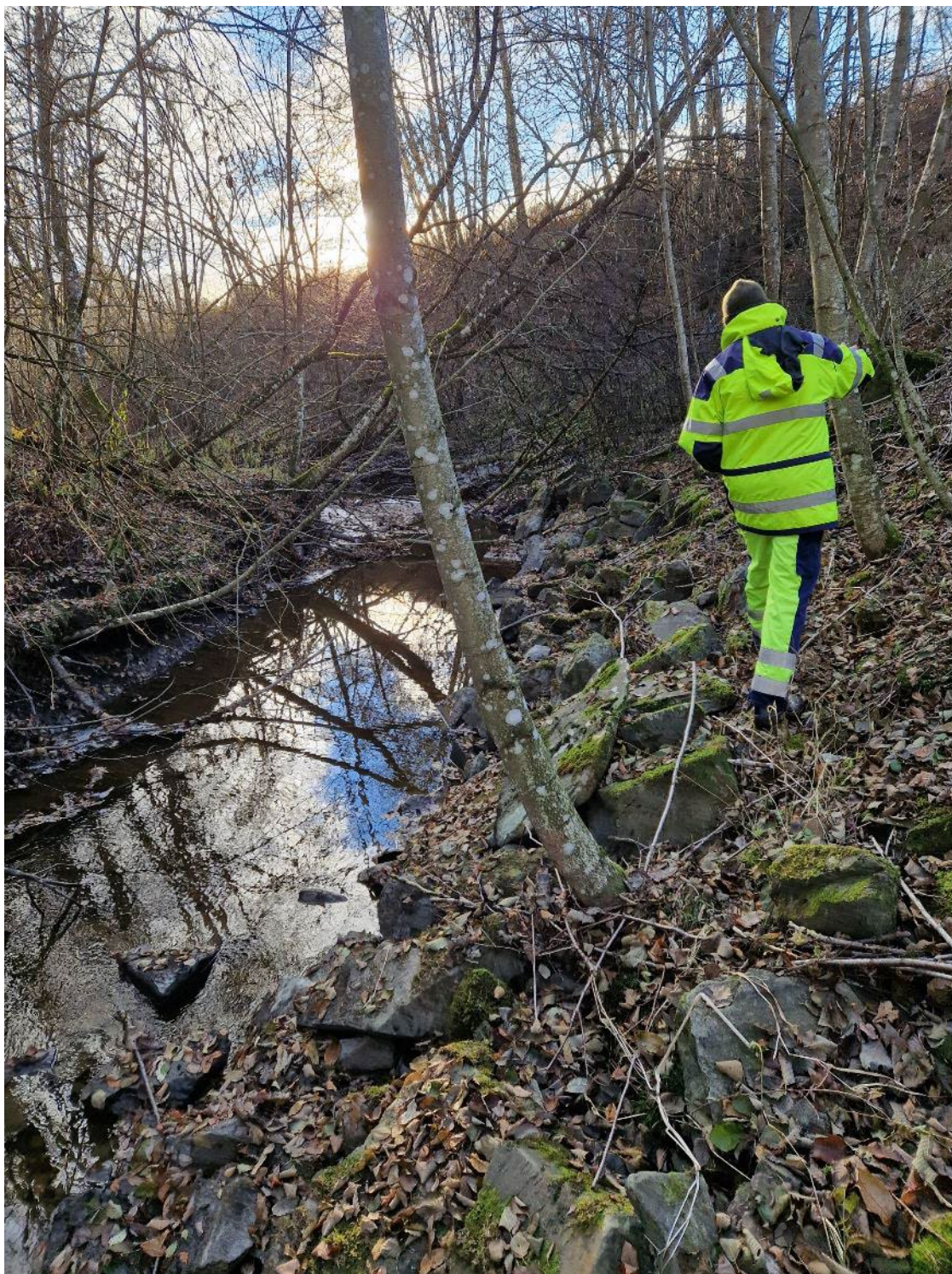
Figur 21 Tidligere erosjonssikring, bilde tatt ned mot enden av det planlagte sikringstiltaket. Der hvor Leiråa renner ut av kvikkleiresonen.
