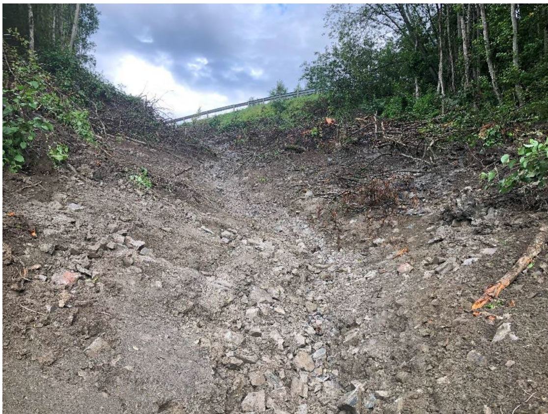
Figur 113 Erosjonssikret sideravine
