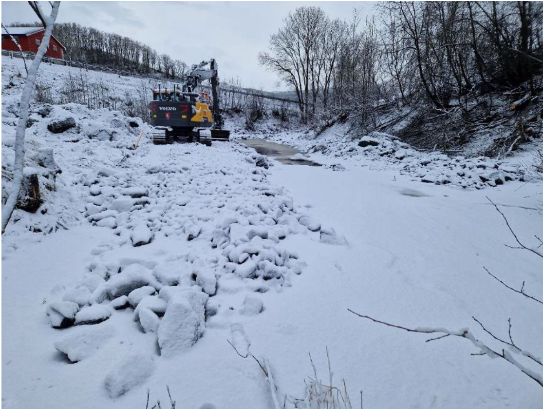
Figur 31 Bilde tatt retning nedstrøms ved starten av tiltaket
