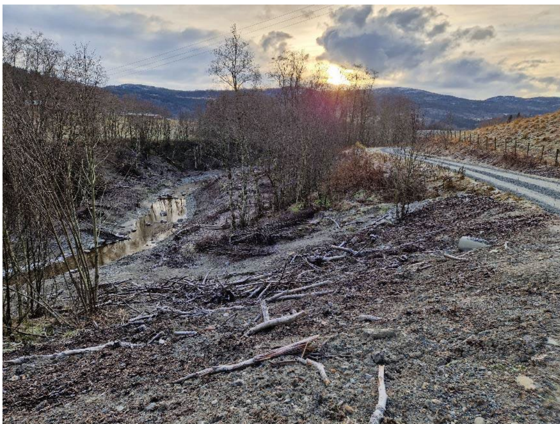
Figur 123 Området ved skredhendelsen, bilde av motfylling og erosjonssikring
