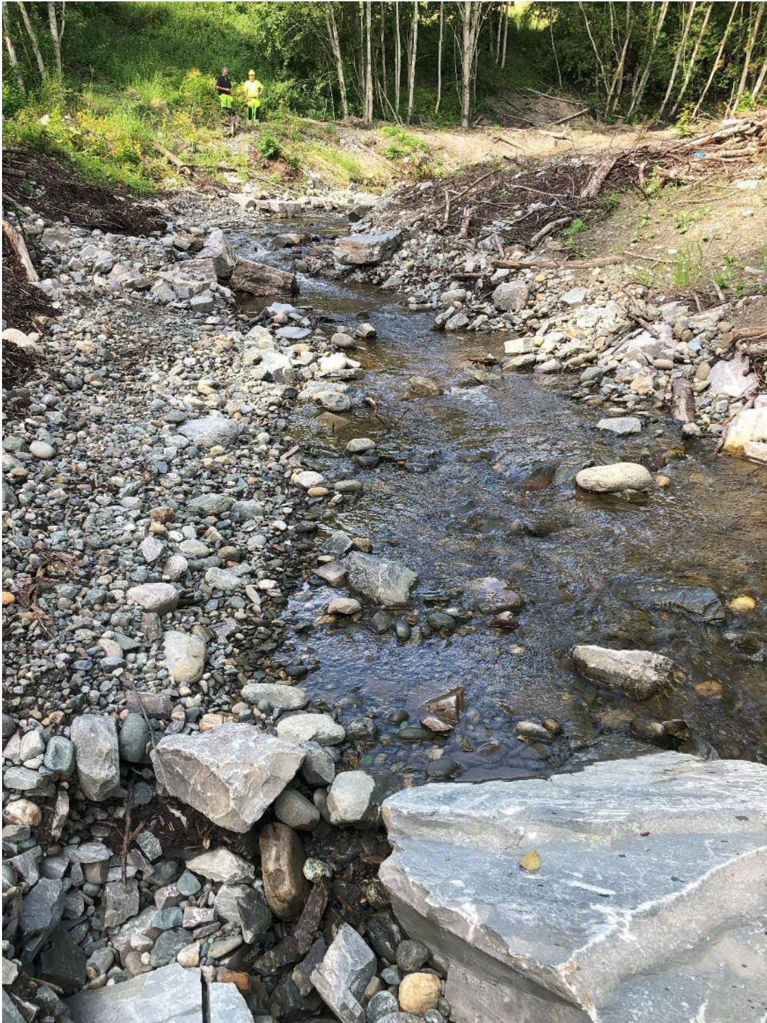
Figur 93 Erosjonssikring i nedre del av tiltaket
