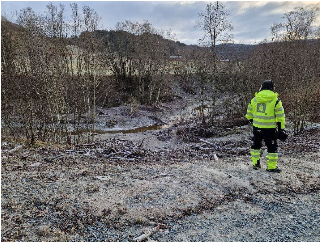
Figur 121 Området ved skredhendelsen, bilde av motfylling og erosjonssikring
