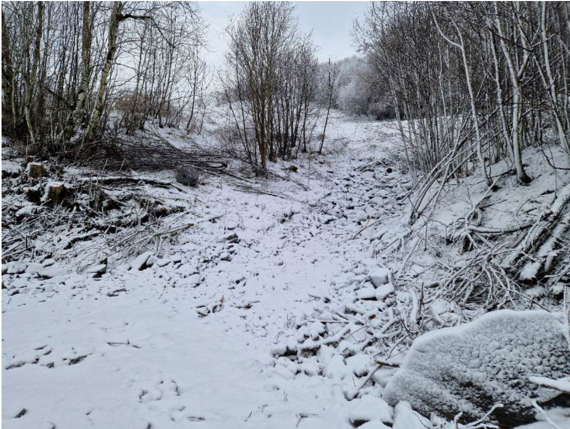
Figur 67 Påbegynt erosjonssikring i sideravine
