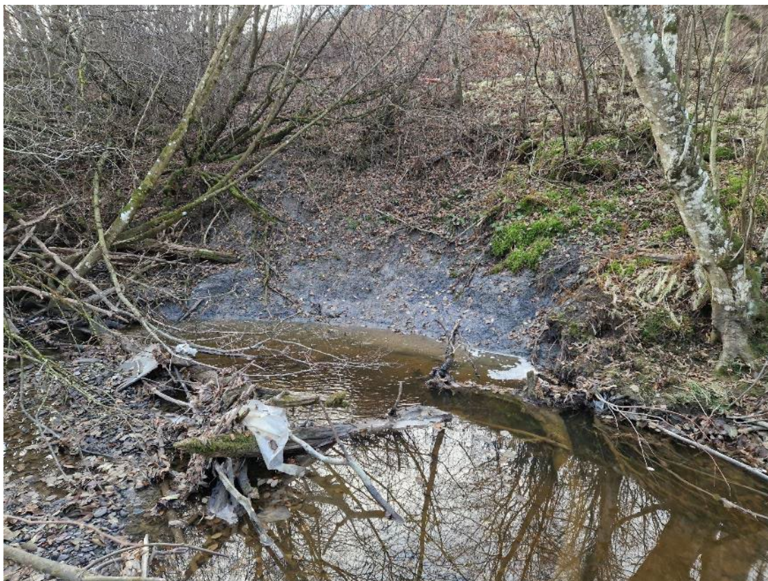
Figur 5 Erosjon i yttersving. Mye drivved og grums ligger i elva, noe som kan øke vannstand og vannhastigheter ved flom og som kan føre til økt erosjon.
