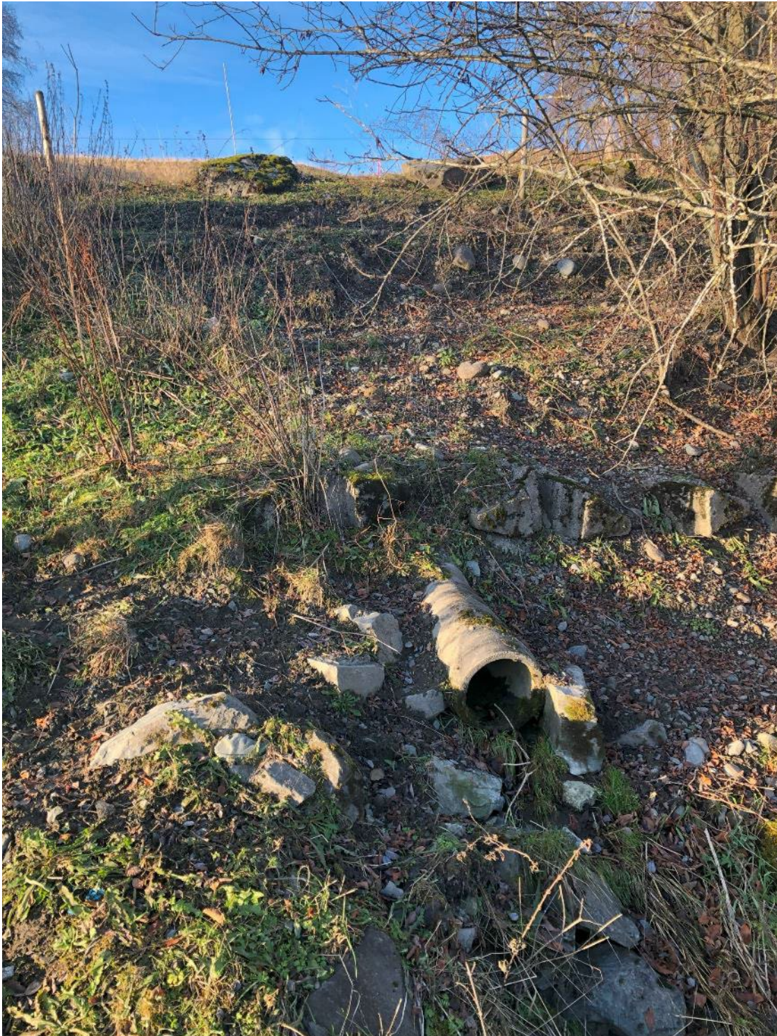
Figur 20 Stikkrenne under veien
