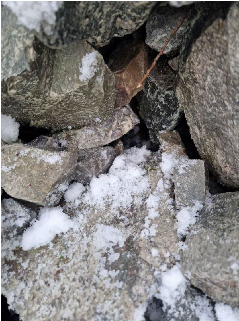
Figur 71 Ikke mye spor av finstoff i sikring nær stedlige masser i denne sideravinen
