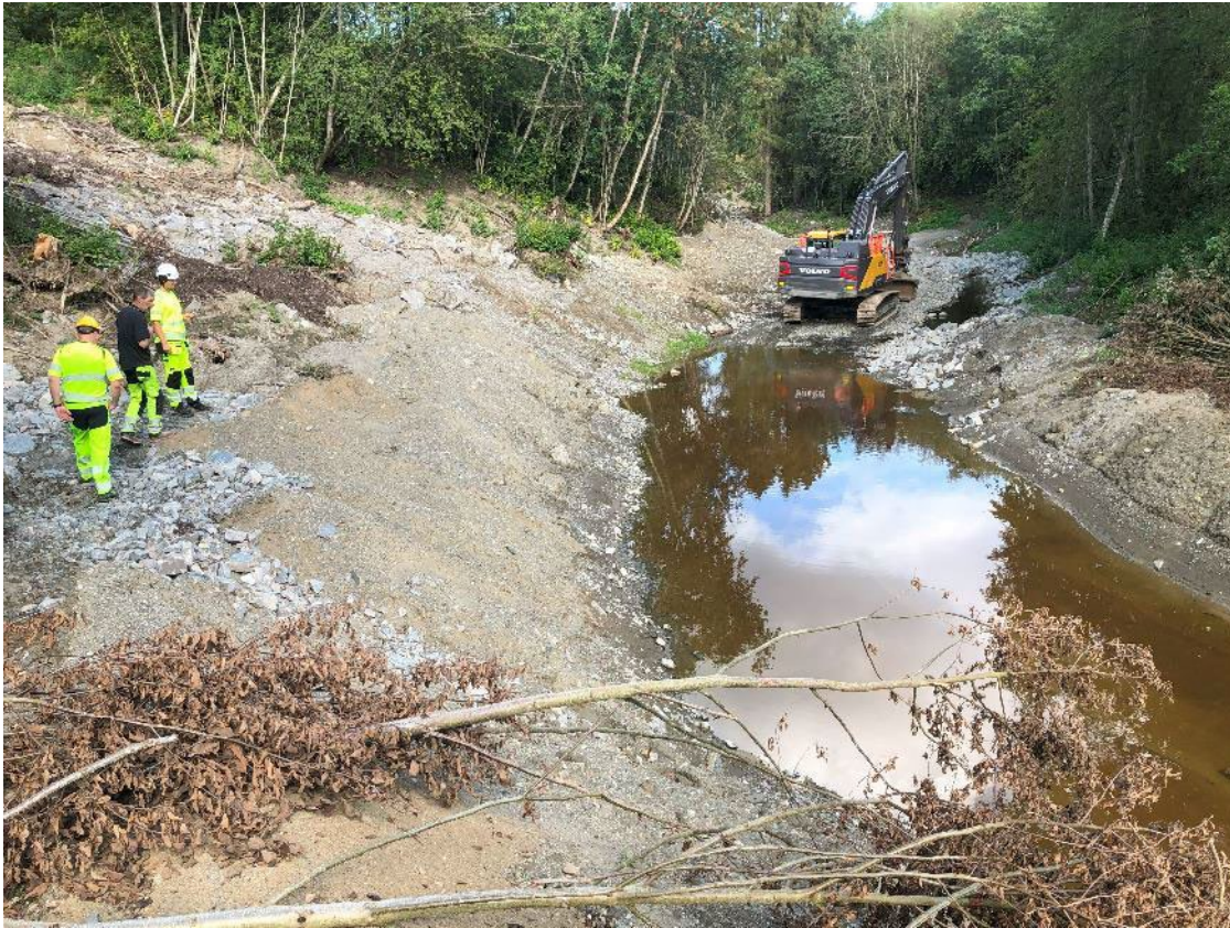
Figur 96 Gravemaskin trekker seg oppover vassdraget og fjerner anleggsveien
