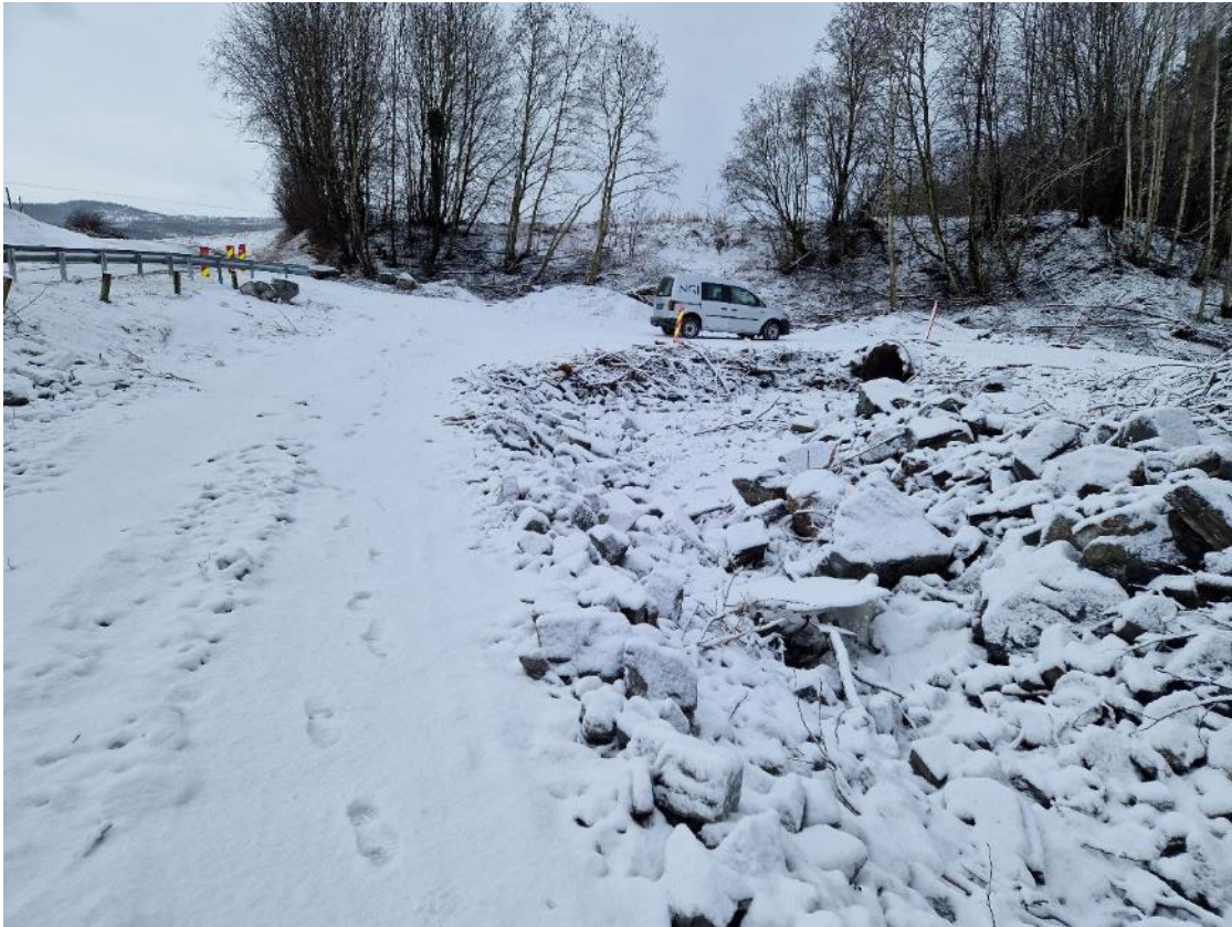
Figur 39 Bilde tatt i retning nedstrøms, ved av-/påkørsel anleggsvei
