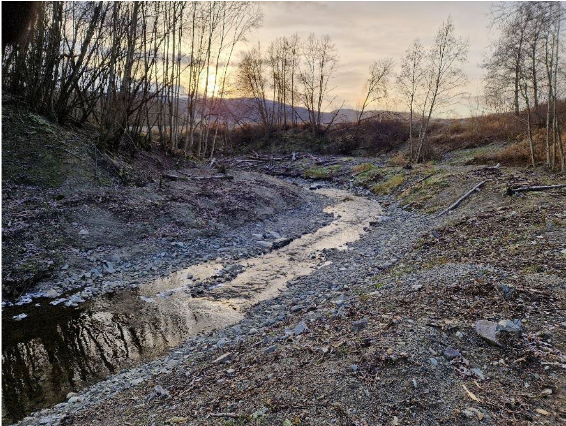
Figur 126 Bilde tatt i retning nedstrøms av erosjonssikringen
