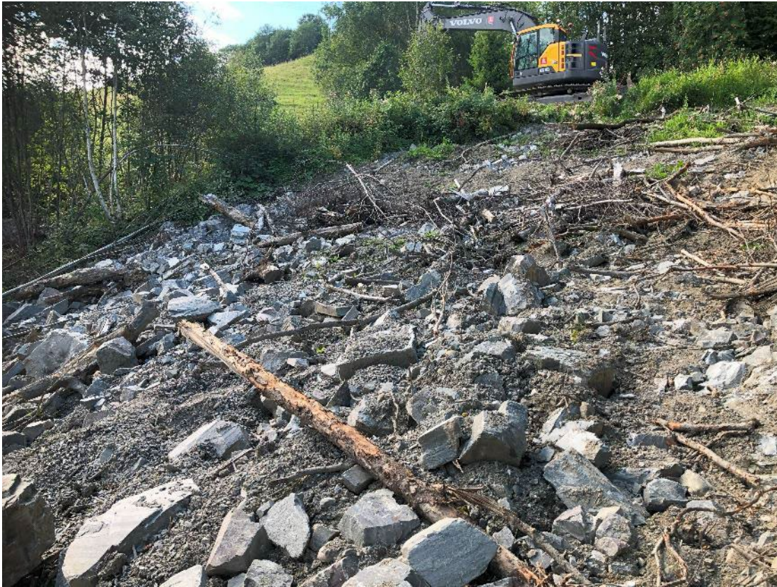
Figur 107 Motfylling ved skredhendelse
