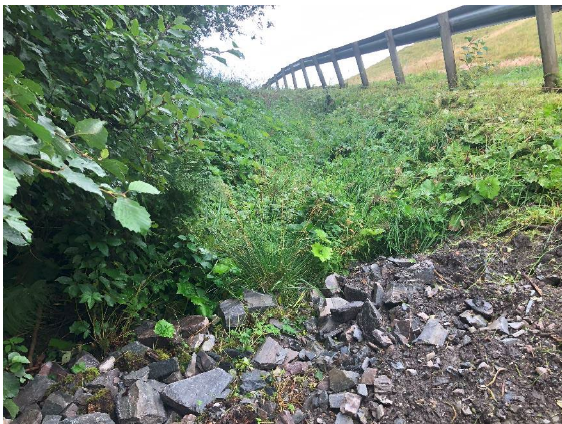
Figur 117 Avslutning av erosjonssikret sideravine
