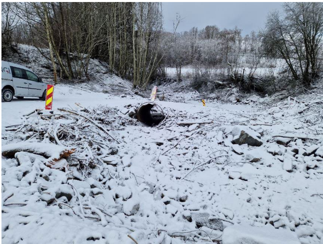
Figur 40 Bilde tatt i retning nedstrøms, ved av-/påkørsel anleggsvei
