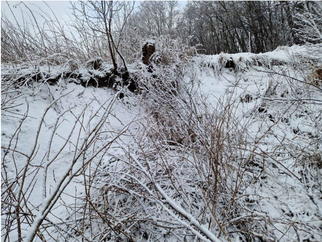
Figur 65 Område rundt skredhendelse sett nedenfra
