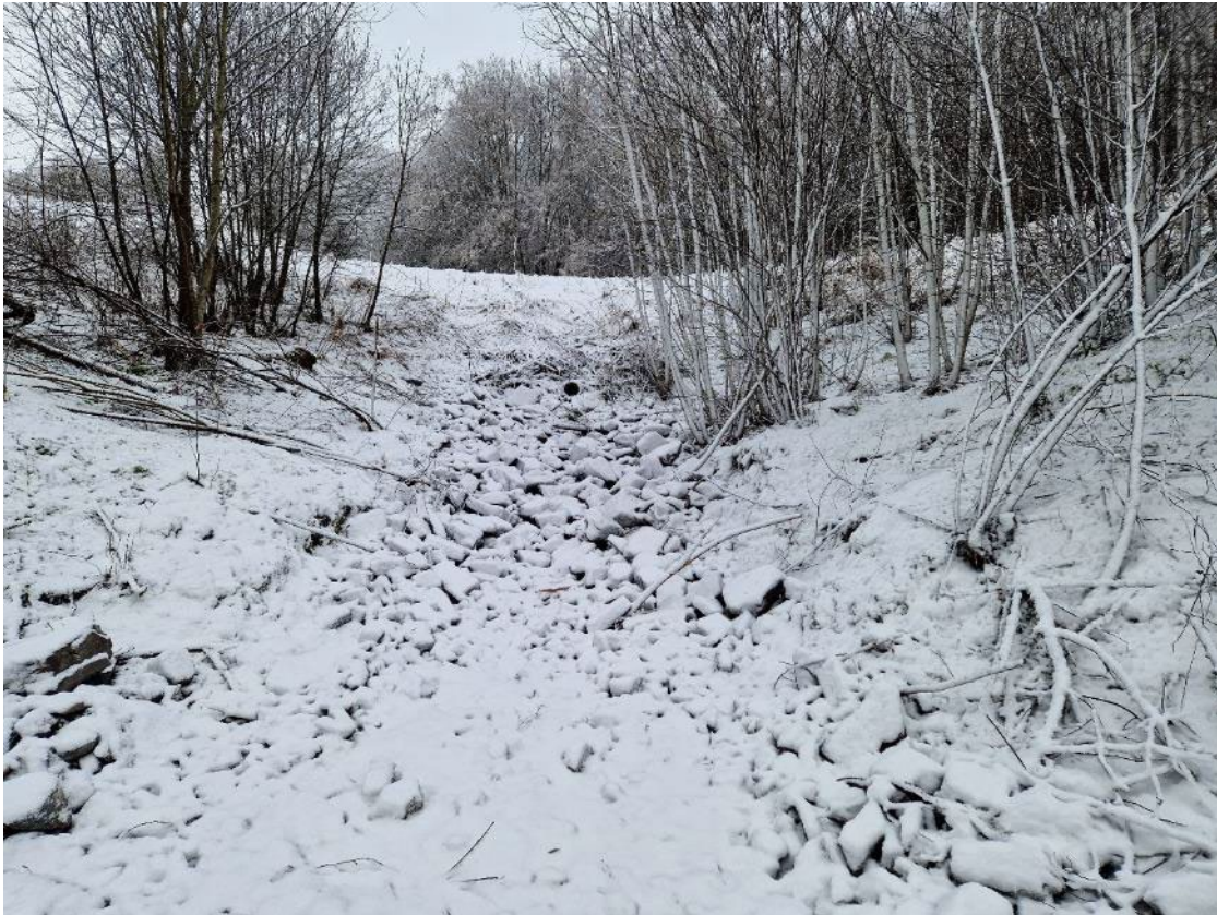
Figur 68 Påbegynt erosjonssikring i sideravine
