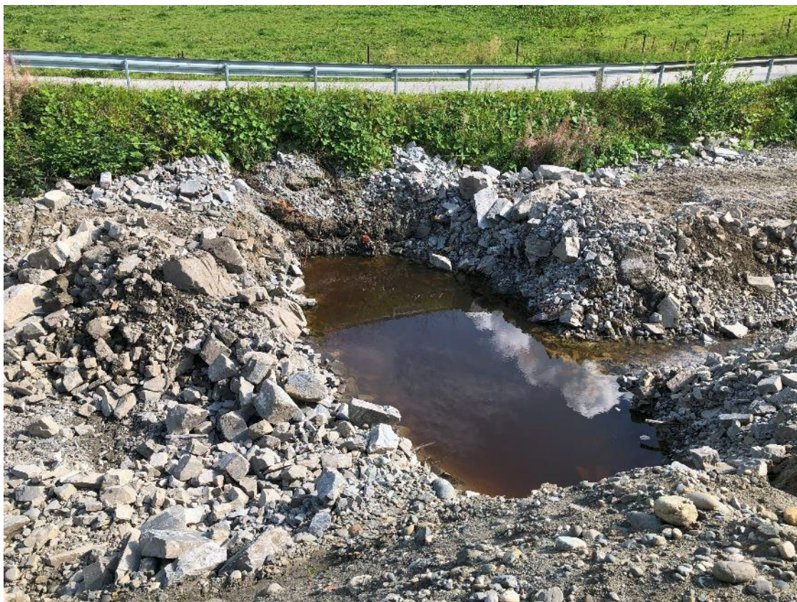
Figur 106 Grop der eksisterende jordbruksdren utløper.
