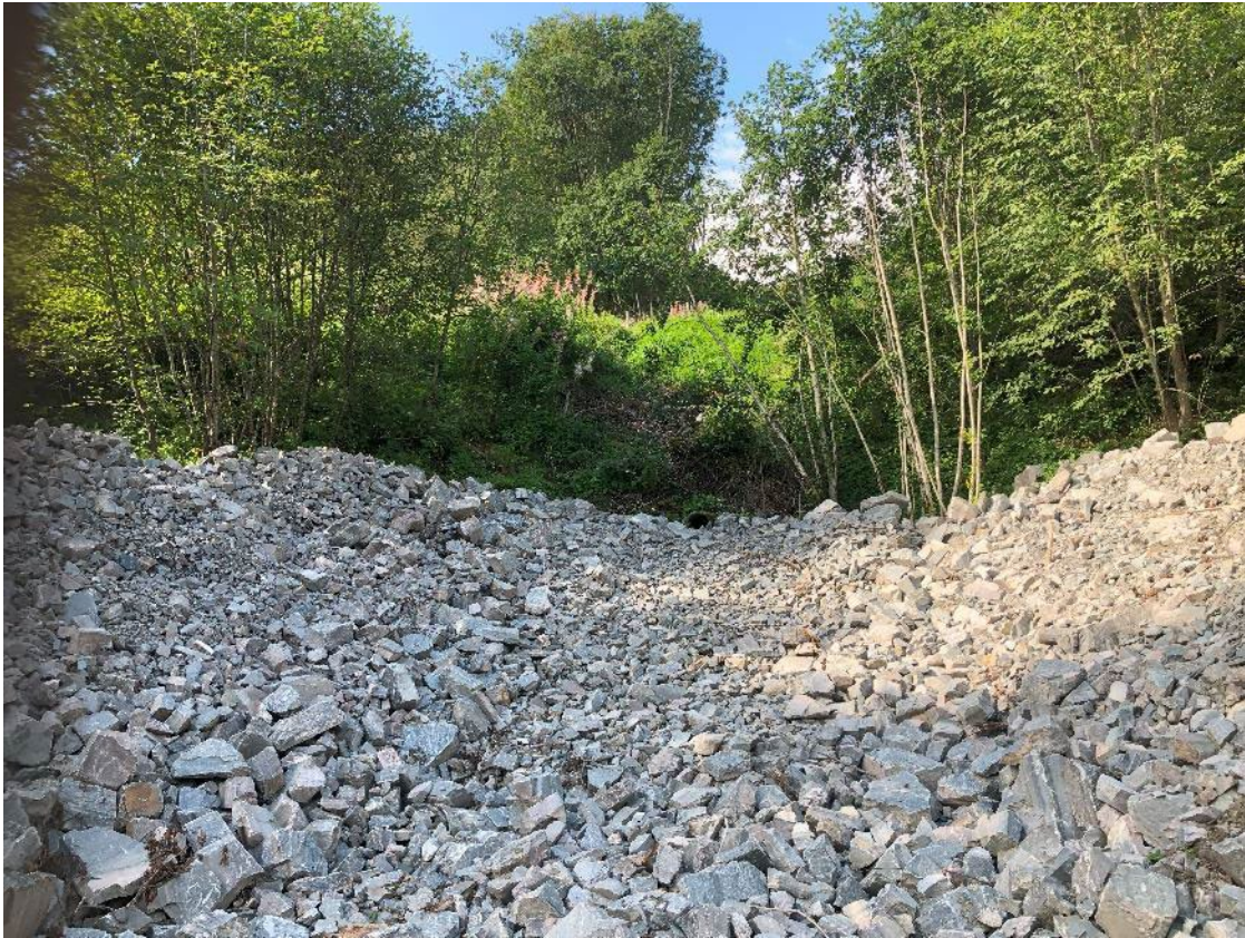
Figur 89 Bilde tatt under utløp av kulvert
