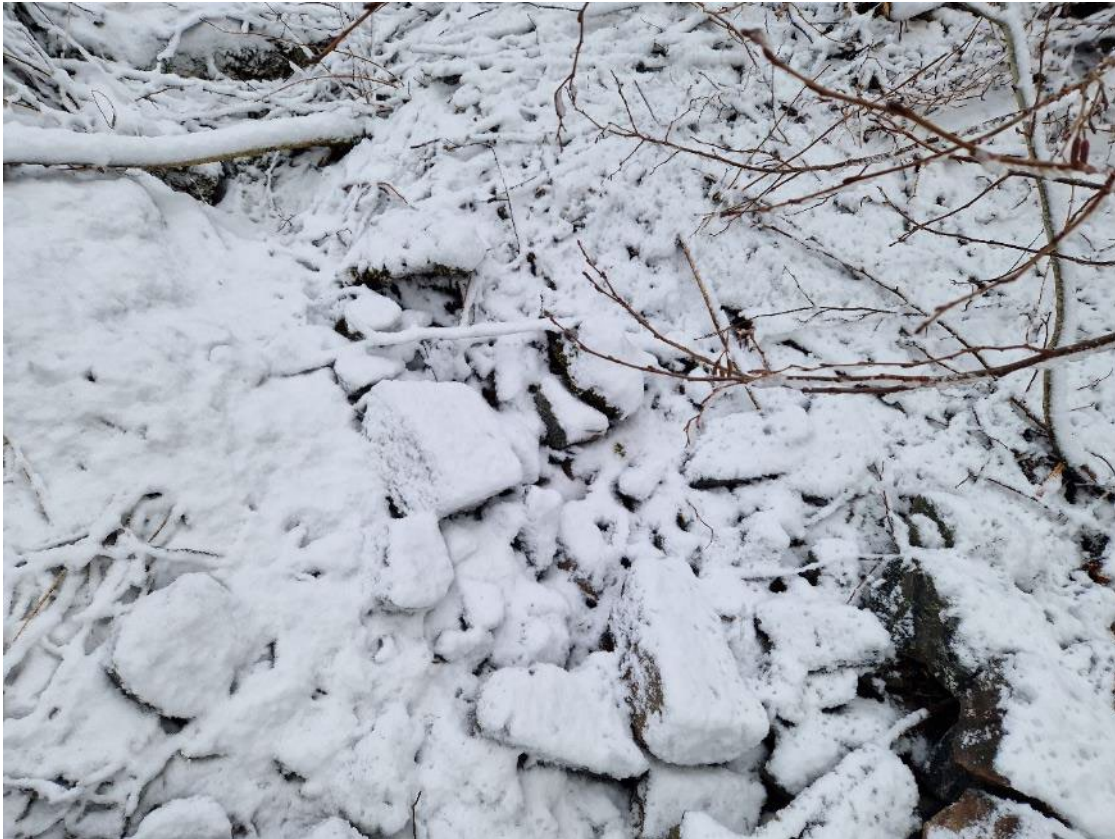
Figur 63 Overgang mellom sikring og stedlige masser
