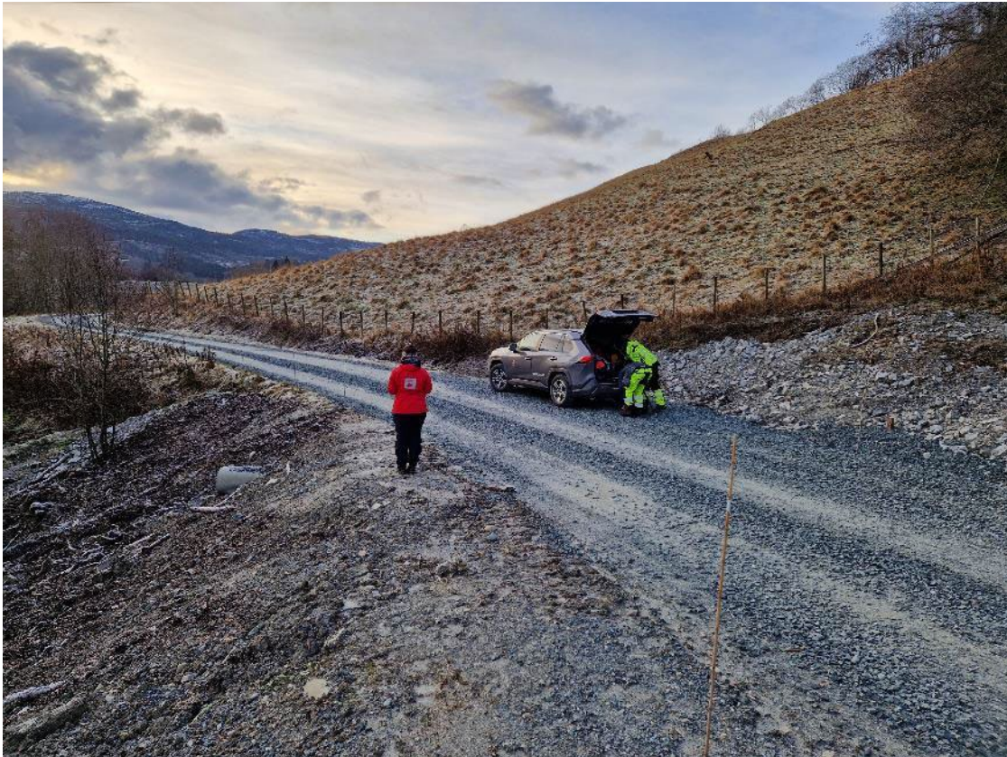
Figur 124 Ny stikkrenne under gårdsveien
