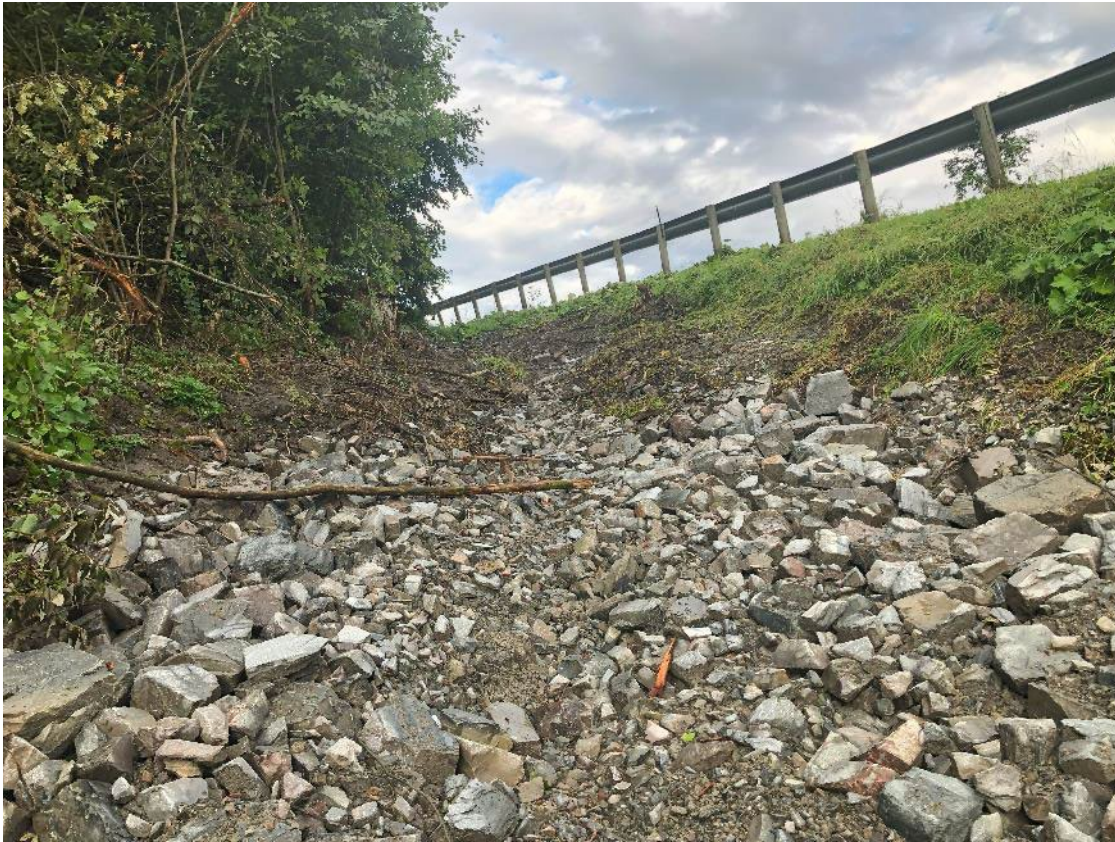
Figur 116 Erosjonssikret sideravine
