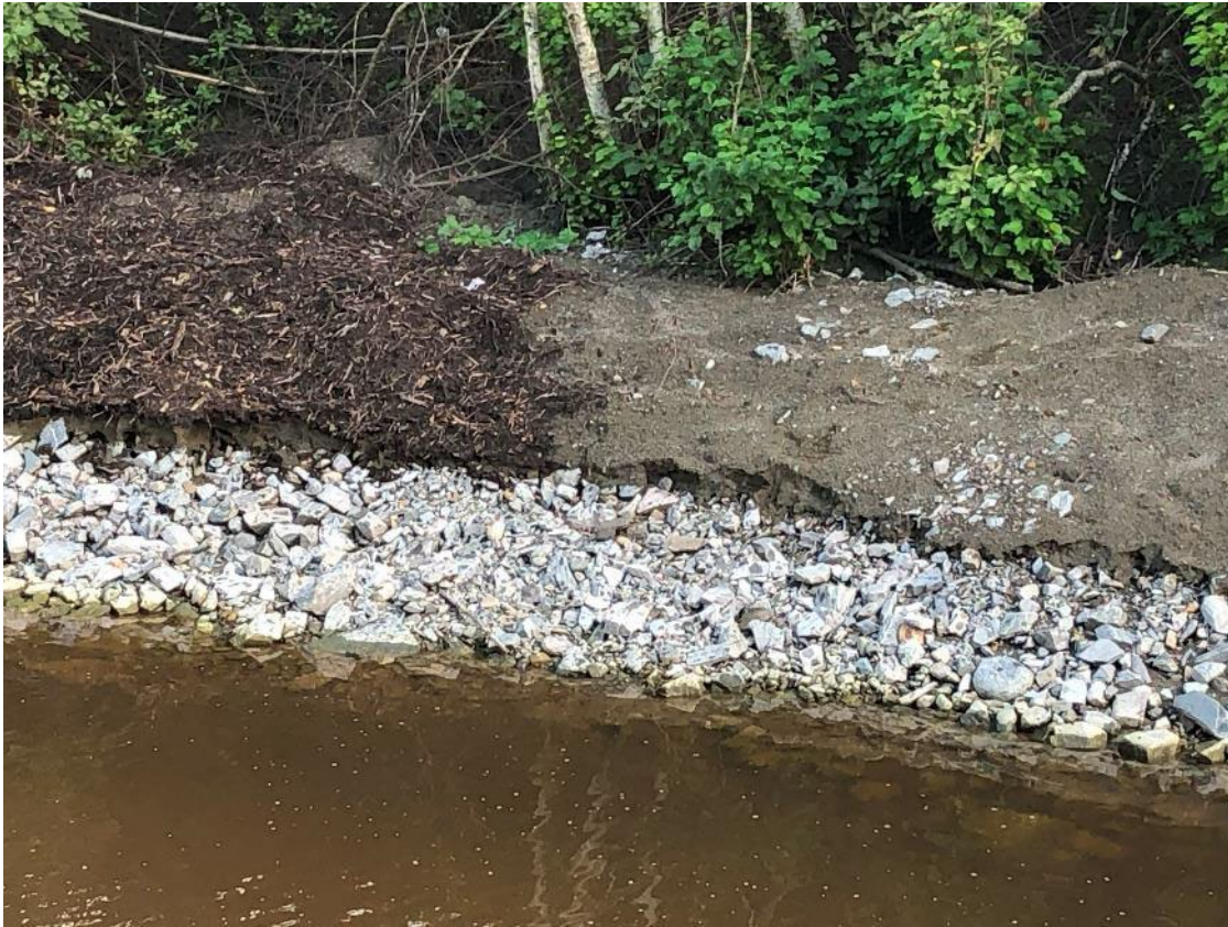
Figur 95 Erosjonssikring
