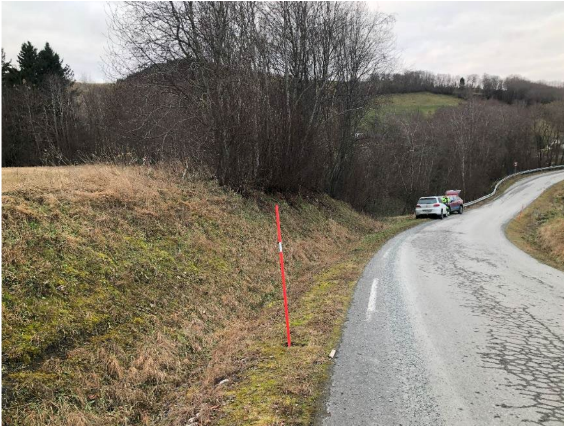
Figur 4 Den aktuelle tilkomsten til anleggsveien ned til sikringstiltaket er ned til venstre ved bilene på bildet.
