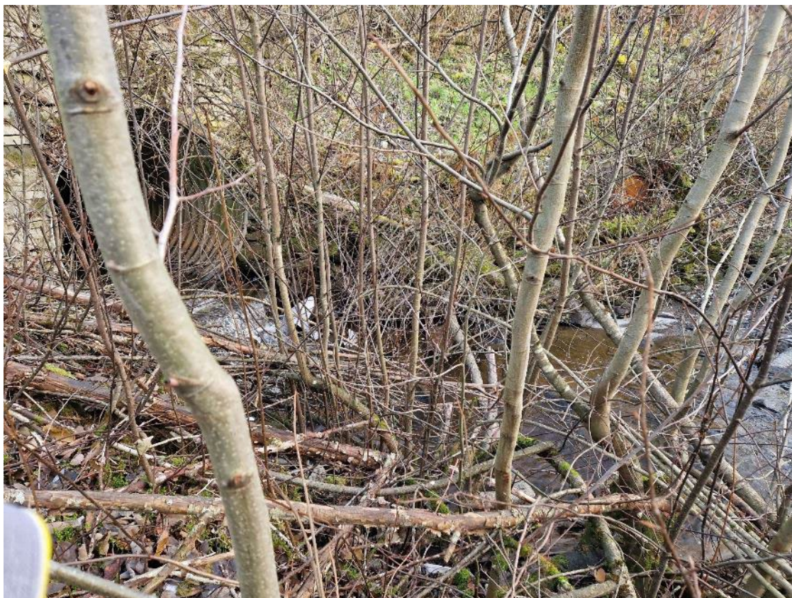
Figur 22 Utløpet nedstrøms kulverten og oppstrøms tiltaket har høyere fall. Det er erosjonssikret i elveløpet her.
