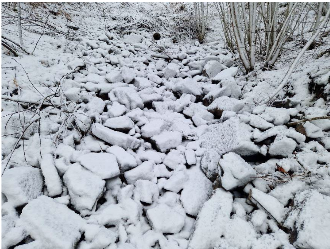
Figur 69 Påbegynt erosjonssikring i sideravine, nedstrøms kulvert
