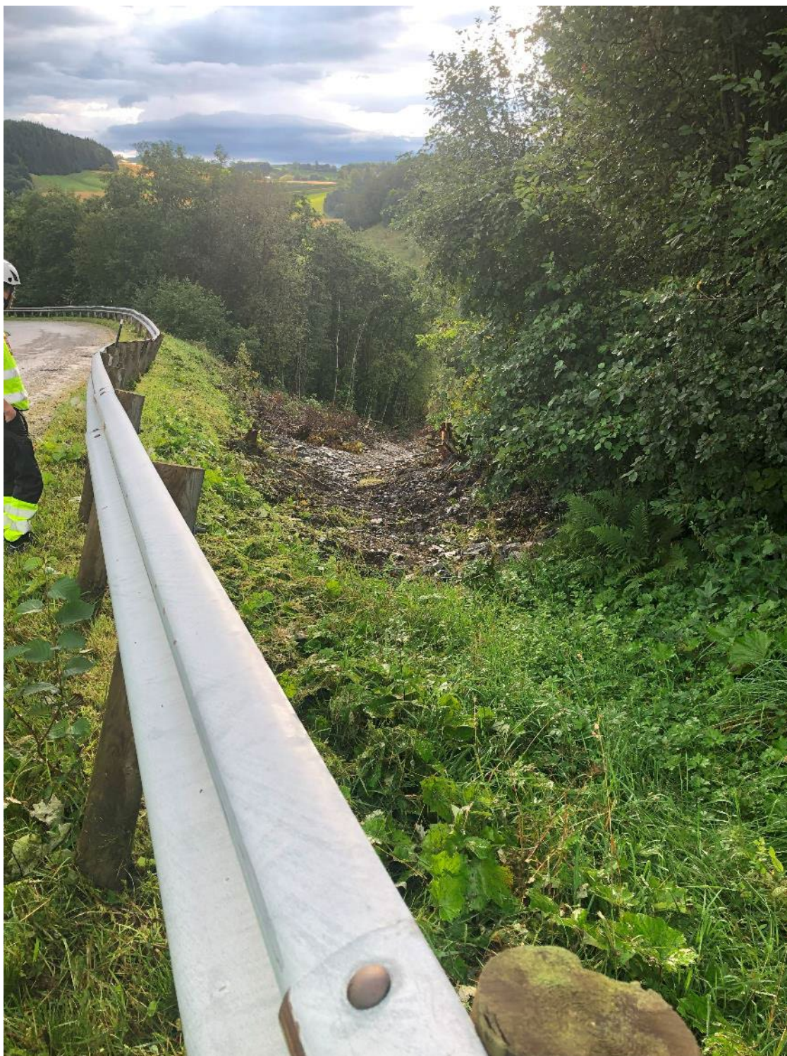
Figur 110 Bilde tatt over sikring av sideravine
