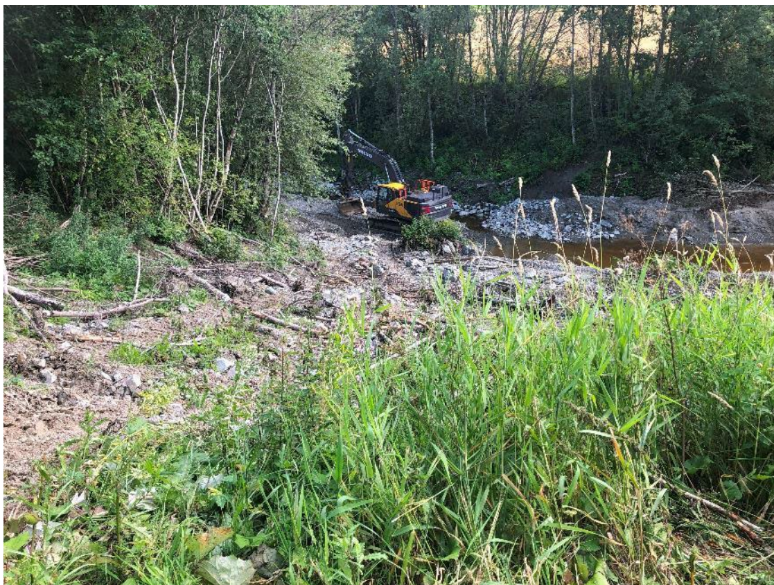
Figur 88 Bilde tatt over skredhendelse ned mot Leiråa
