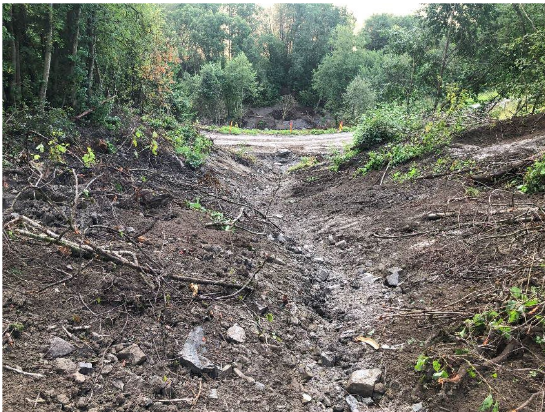
Figur 119 Bilde tatt ned erosjonssikret sideravine
