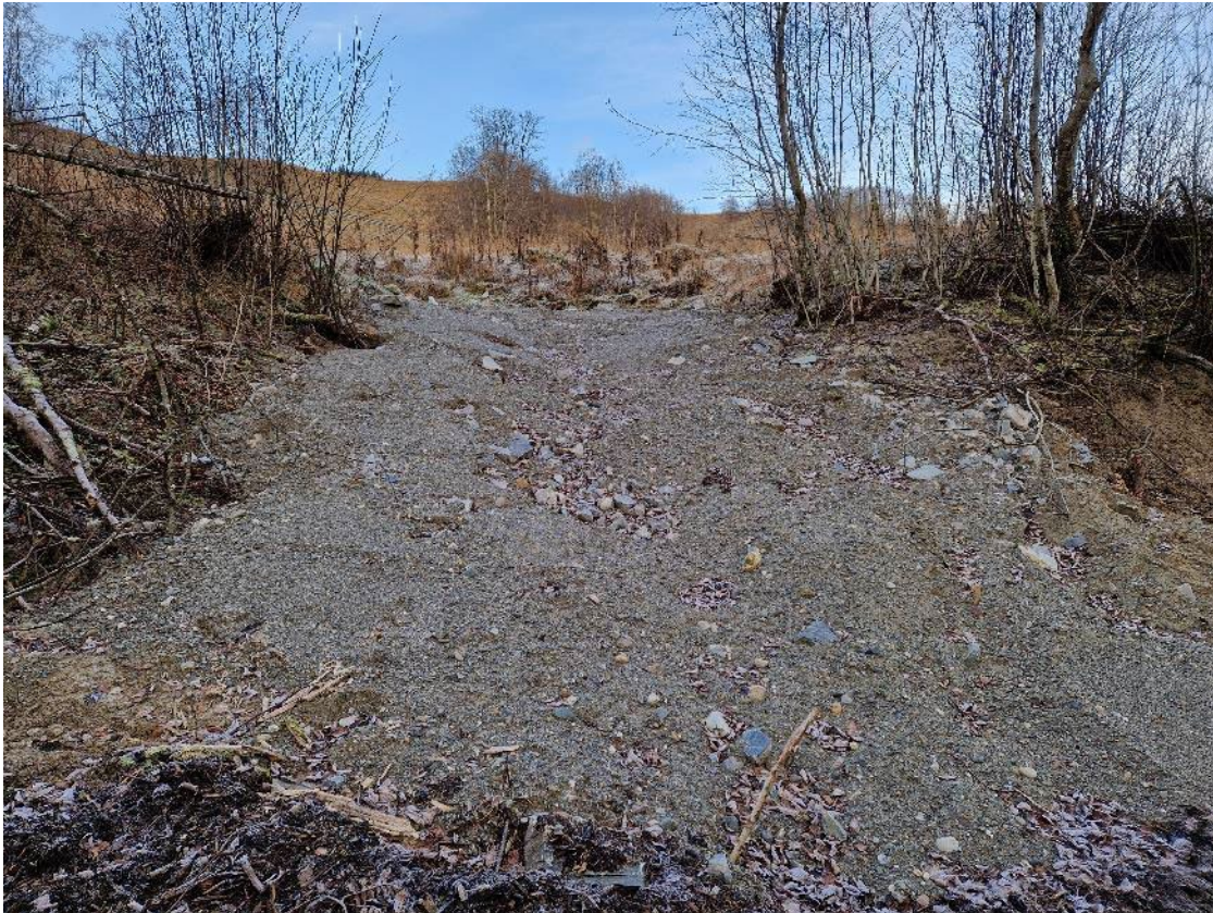
Figur 130 Erosjonssikret sideravine
