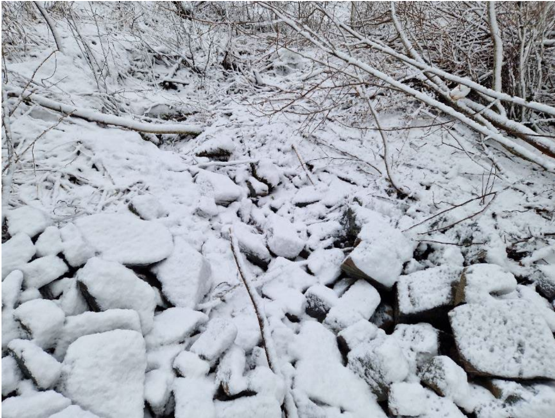
Figur 62 Overgang mellom sikring og stedlige masser
