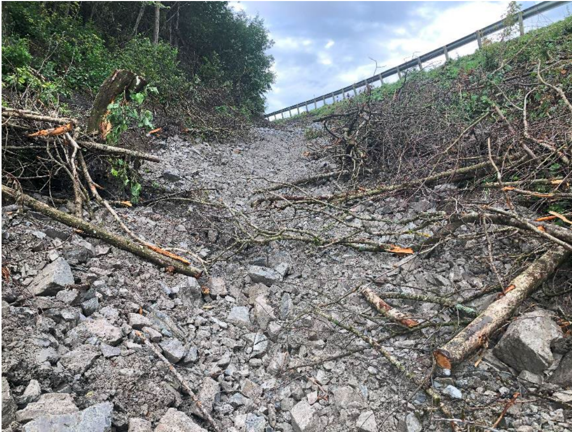
Figur 115 Erosjonssikret sideravine
