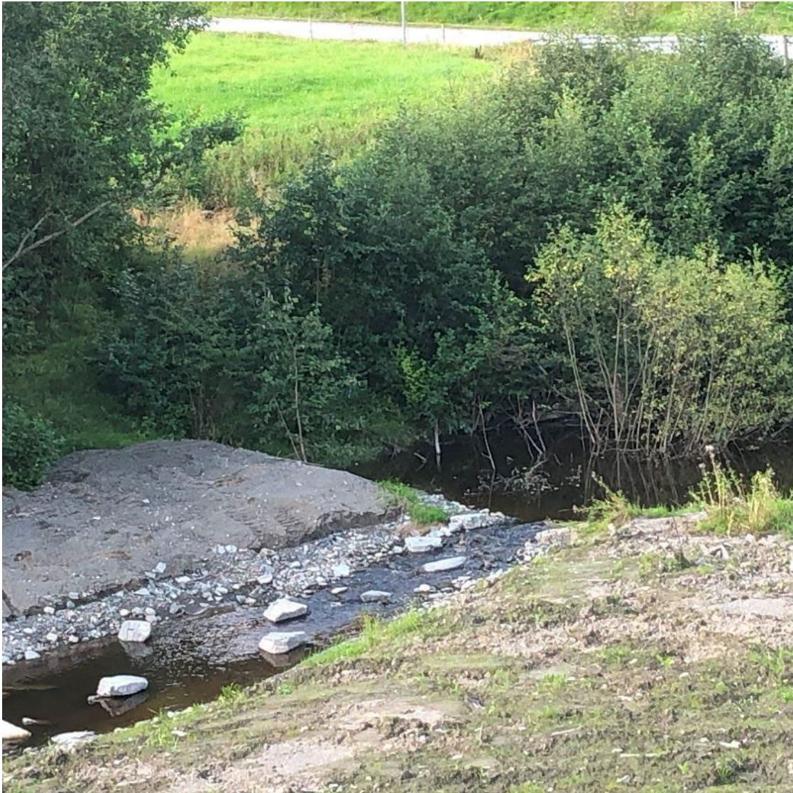
Figur 109 Dam i starten av tiltaket
