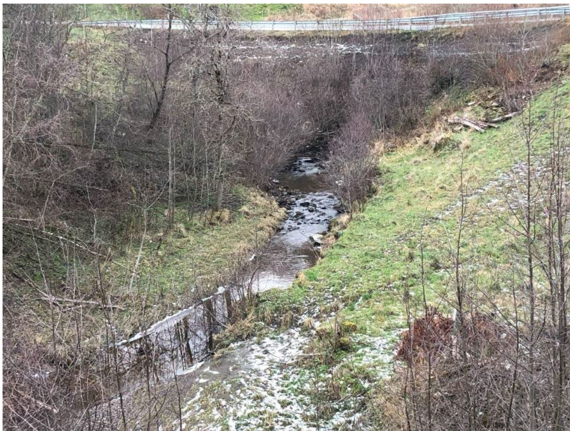
Figur 3 Øvre del av aktuelt sikringstiltak, kulvert under Leiråveien midt i bildet. Området rett nedenfor kulverten er steinsatt tidligere. Erosjonssår i elvens yttersving vises nede til venstre i bilde.
