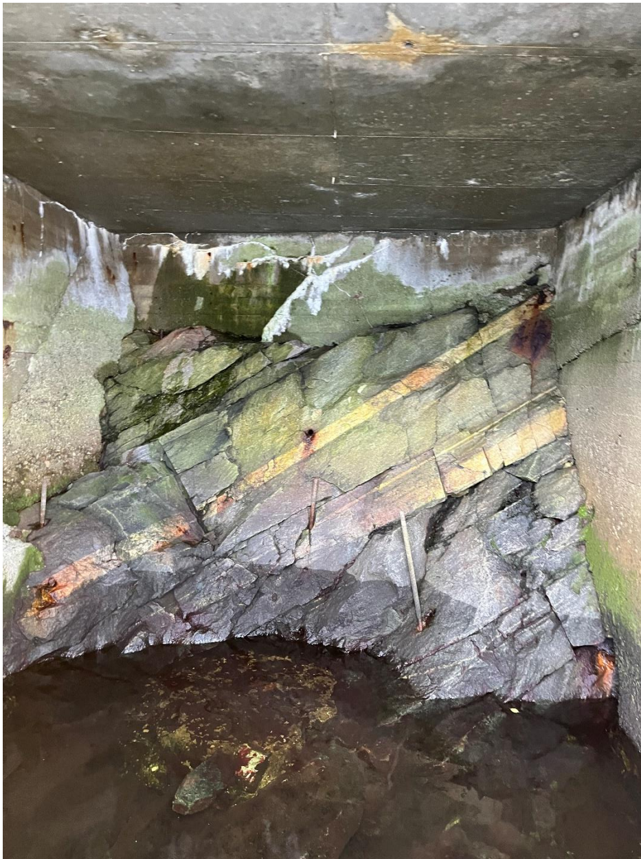
Figur V.2: Bilde ved vannoverflaten under eksisterende kai som illustrerer at bunnforhold i området er preget av fast fjell som forlenges ned i sjø. Foto: Kine Øren/Sweco
