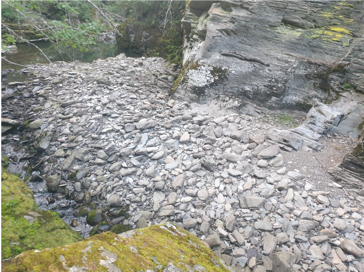
Figur 6: I bakkant av dammen fra 1910 i Våla, ligger det et betydelig kvanta stein- og grusmasser. (Foto: Tore Solbakken, GSFF).
