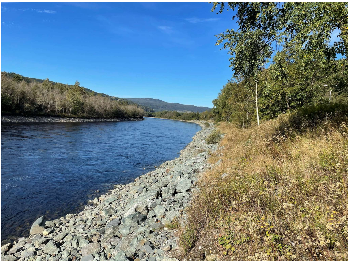
Figur 4-2 Forbygd elvebredd sett fra helt i øvre ende av faresonen og nedstrøms. (Foto: Norconsult 17.09.2021)
