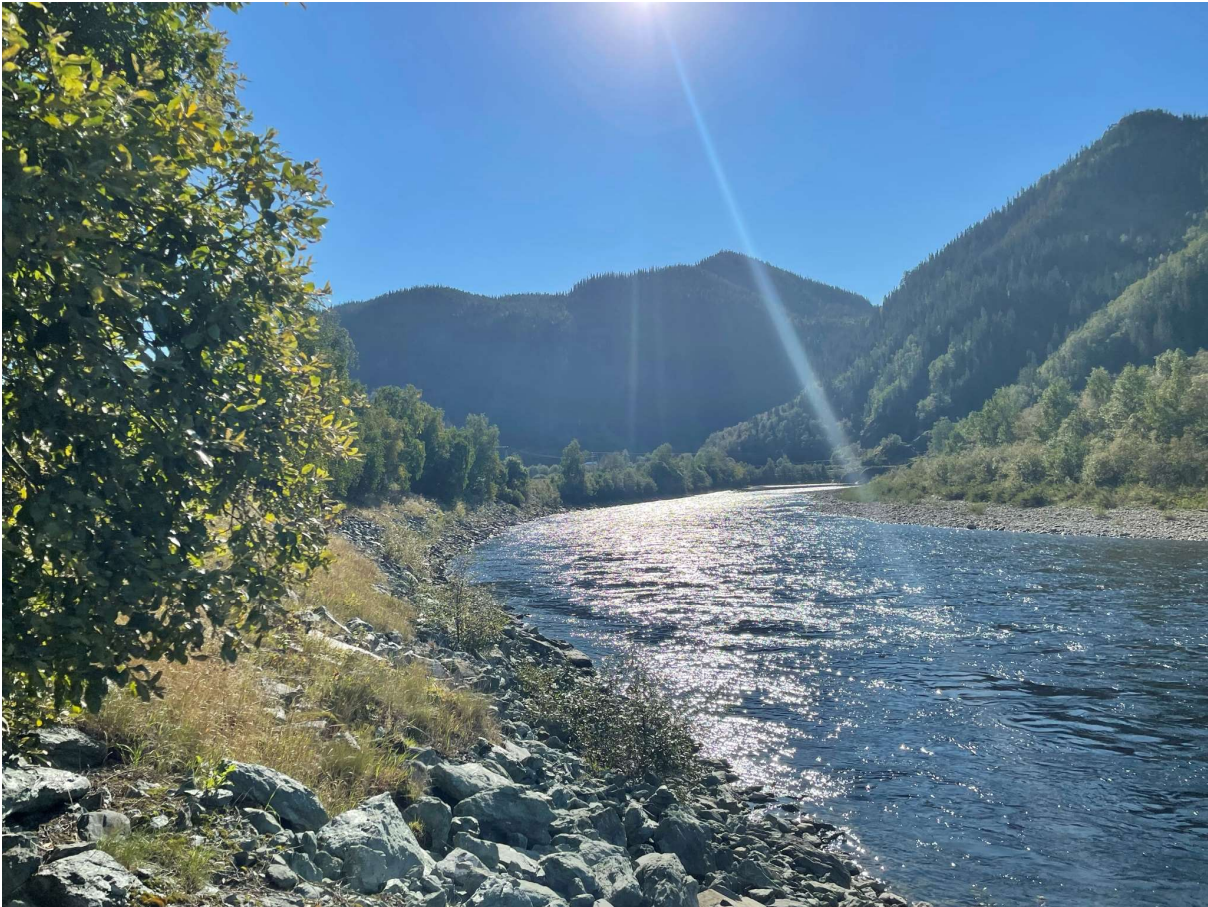
Figur 4-3 Gaula oppstrøms faresone Gyllan. Forbygningen viser grov plastring. (Foto: Norconsult 17.09.2021)
