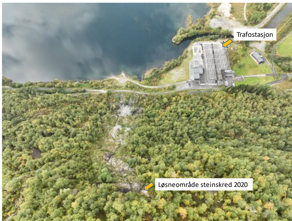
Figur 4-1 Sår i terrenget etter skredet som gikk i 2020 sør for eksisterende trafoanlegg.
