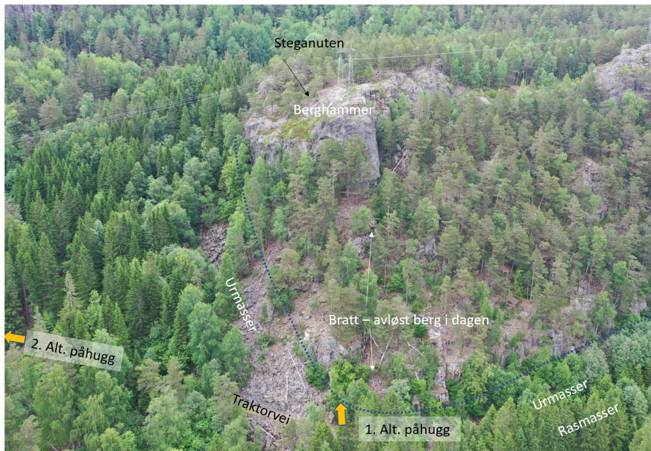
Figur 5-8 Dronefoto med oversikt over opprinnelig påhuggsplassering for adkomsttunnelen til Suldal 2B kraftverk.
