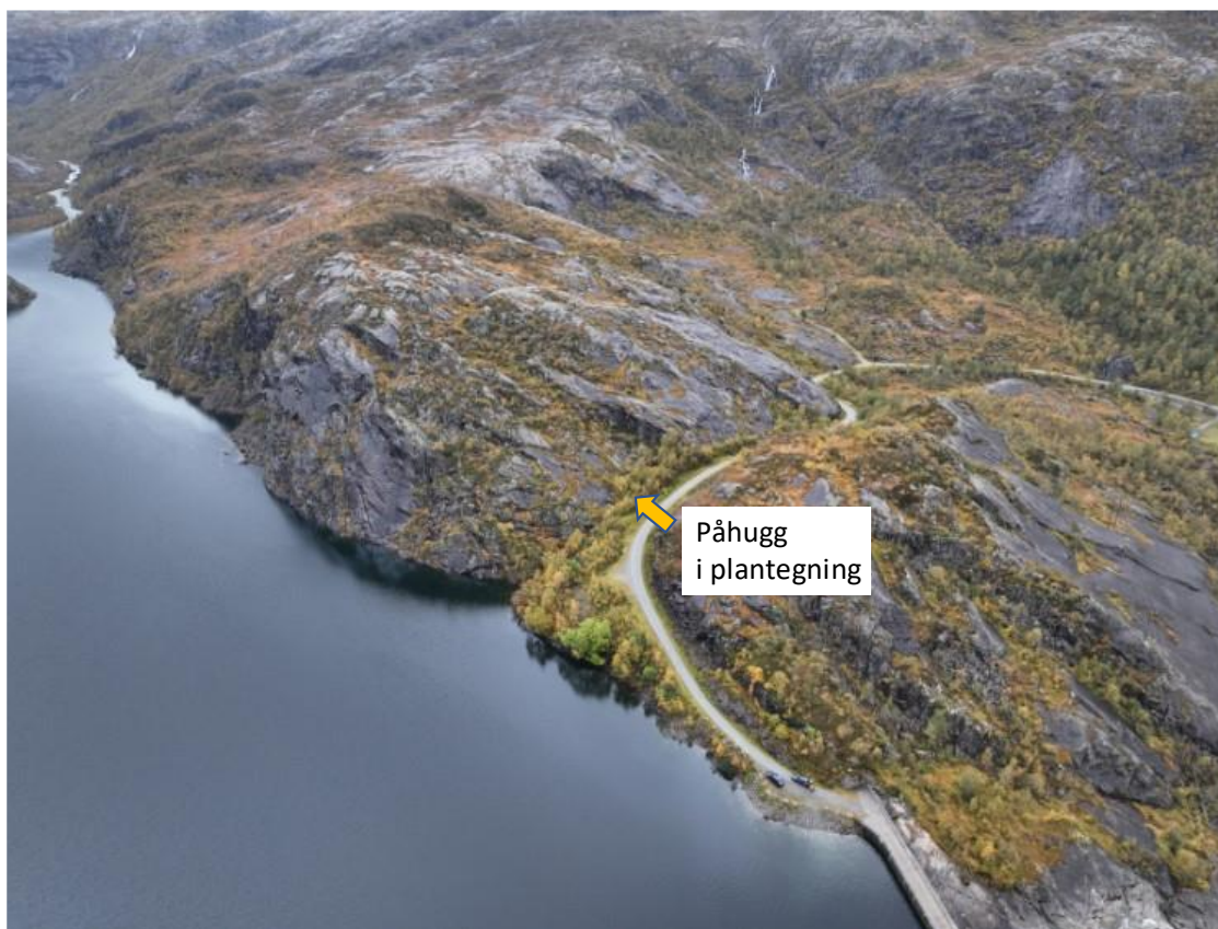
Figur 5-1 Dronefoto tatt mot NØ som viser påhugget for tverrslag lukesjakt ved Kvanndalsfoss.
