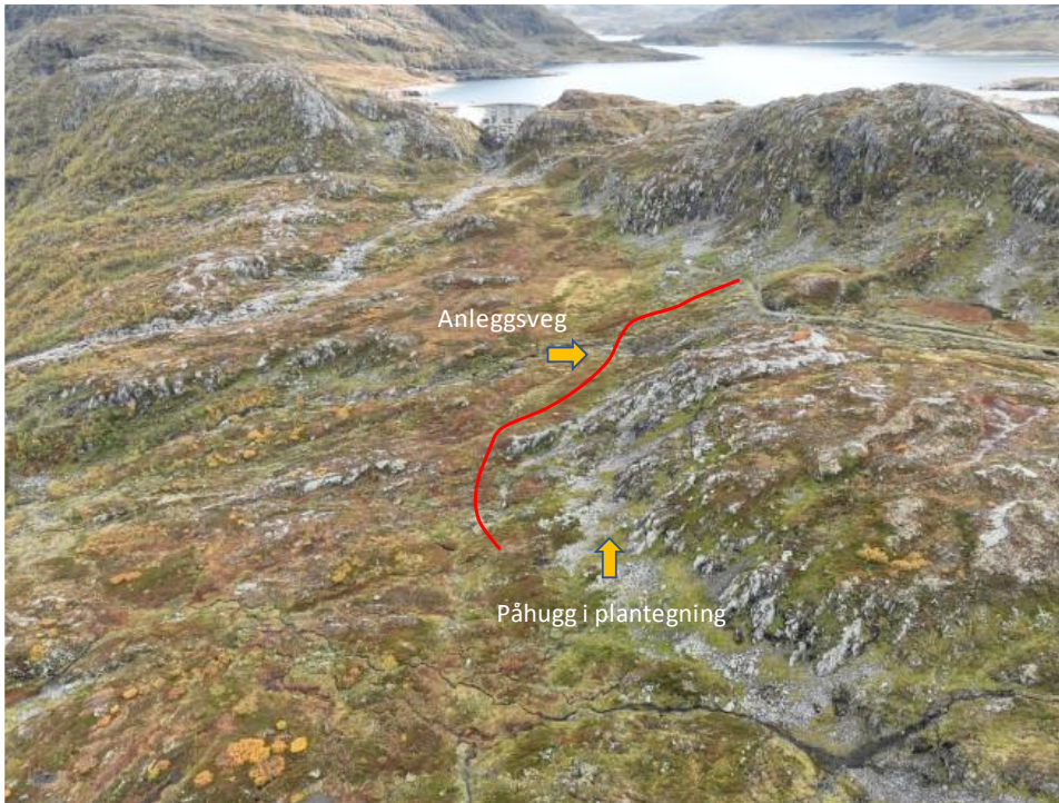
Figur 4-10 Dronebilde tatt mot SØ som viser anleggsvegen fra Fossen samt påhuggsplassering for tverrslaget.
