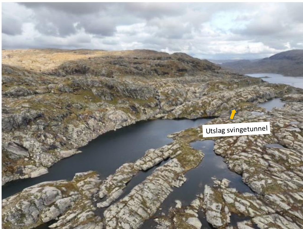
Figur 5-4 Dronebilde tatt mot øst som viser utslag svingetunnel 1080 moh.
