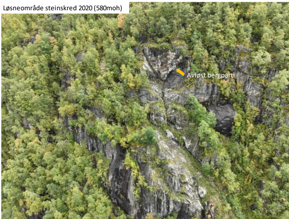
Figur 4-2 Dronebilde av løsneområdet for steinskredet som gikk i 2020. Et større avløst bergparti henger igjen på 580moh. Dette avløste partiet er sikret [10].
