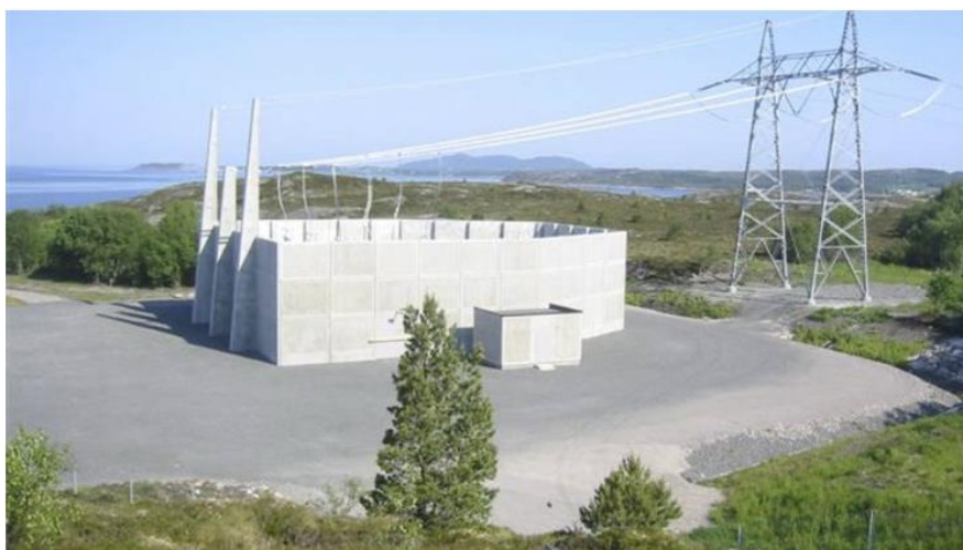
Figur 8: Eksempel på muffehus for en ledning
