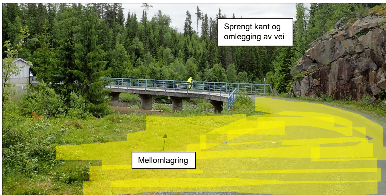
Figur 3-10: Område til mellomlagring av sprengstein. Bildet er tatt av Norconsult.
