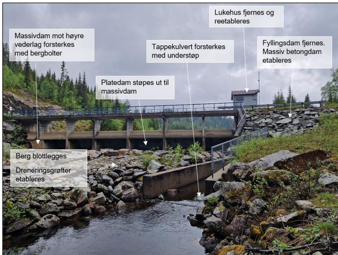
Figur 3-1: Tiltak på damanlegget.
