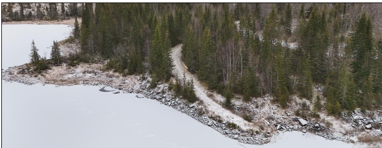
Figur 3-15: Eksisterende grusvei skal lede ned til midlertidig fangdam. Bildet er tatt av Norconsult.
