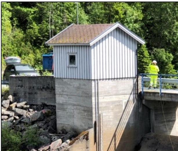
Figur 3-20: Eksisterende lukehus, sett fra oppstrøms side. Bildet er tatt av Norconsult.
