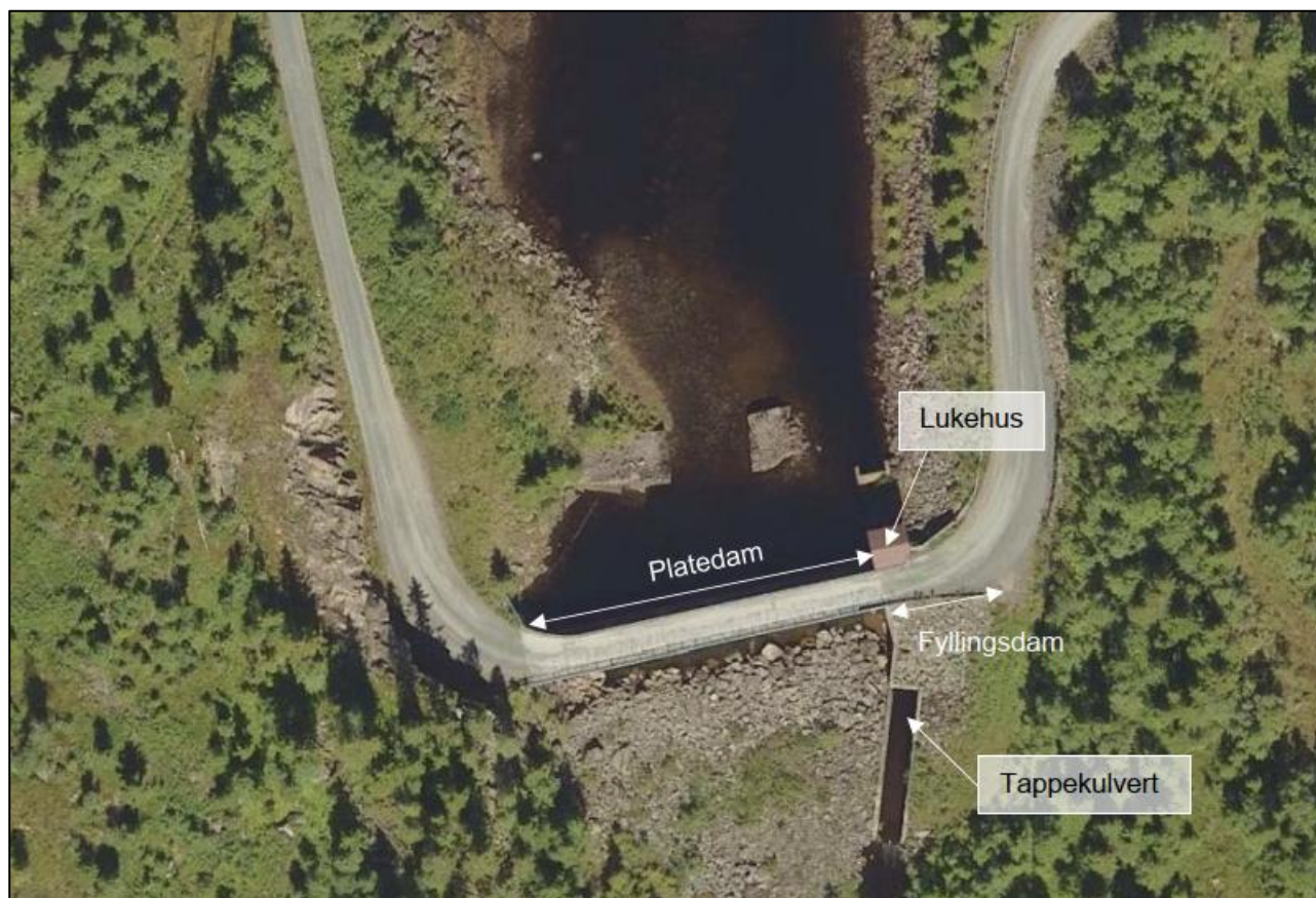
Figur 1-1: Damanlegget ved Hovdevatn (Flyfoto NVE Atlas).
