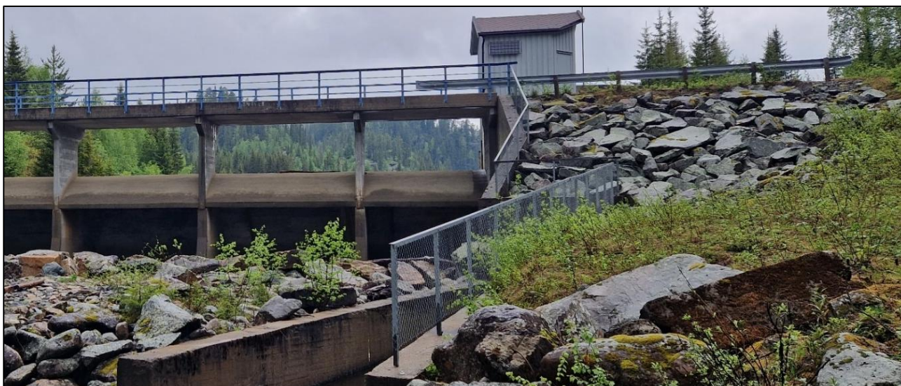
Figur 3-16: Fyllingsdam, sett nedstrøms. Bildet er tatt av Norconsult.
