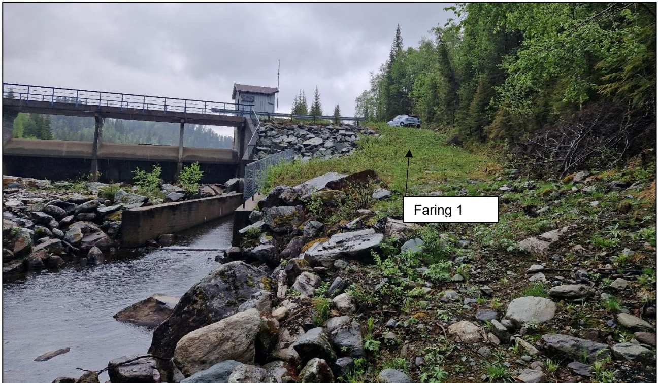
Figur 3-13: Midlertidig faring nedstrøms. Bildet er tatt av Norconsult.
