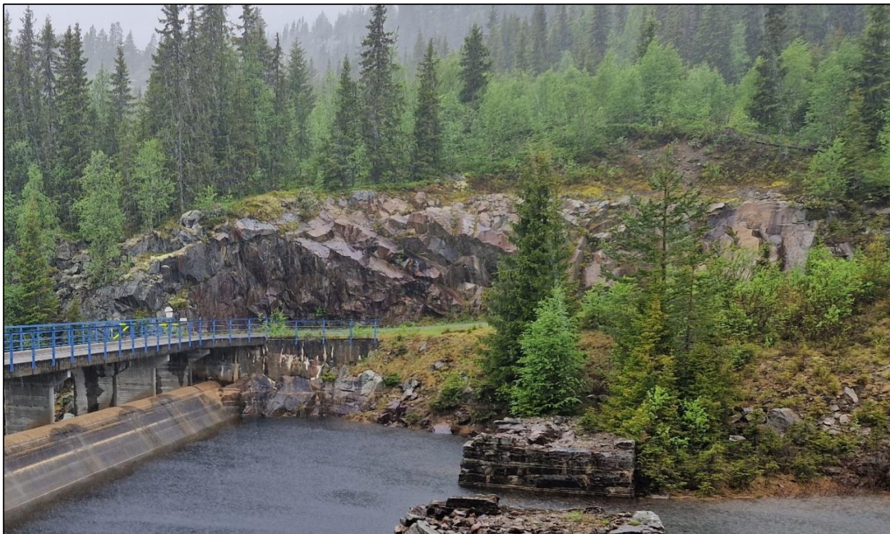
Figur 3-12: Dagens situasjon av sprengt bakvegg. Bildet er tatt av Norconsult.
