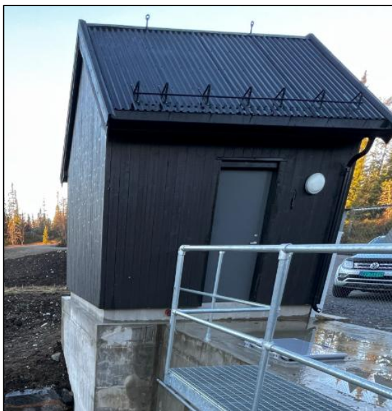
Figur 3-21: Lukehus på Gjuvåa kraftverk. Ulikt produkt som på Hovdevatn, men har stående tett i beisa, og vil dermed ha et likt utseende.
