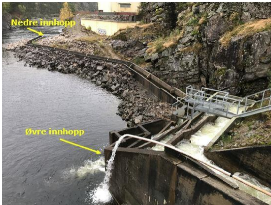
Figur 6: Fisketrappa sett fra dammen, med nedre og øvre innhopp. Vannslipp fra rør er et forsøk på attraksjonsvann. Figuren er hentet fra konsesjonssøknaden s. 18 (Figur 2-13).
