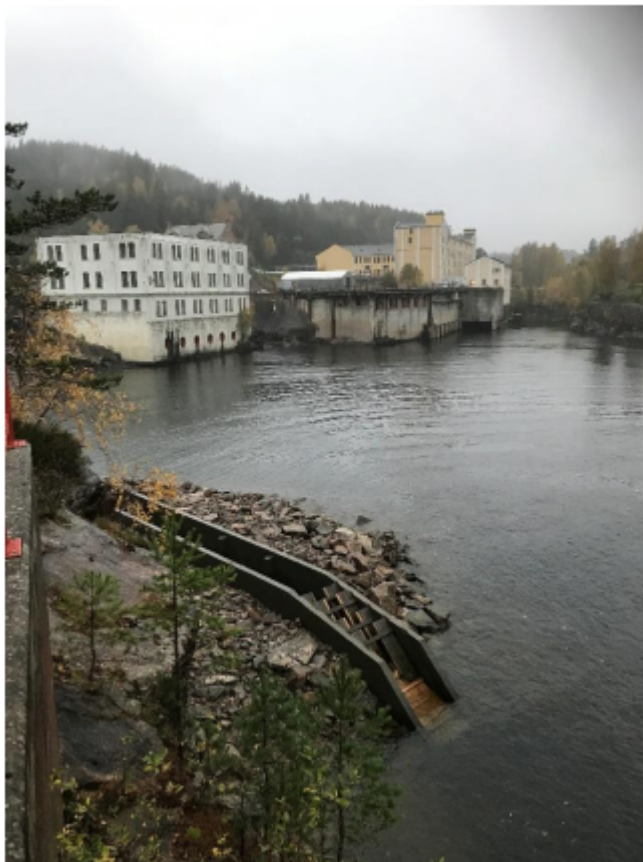
Figur 7: Nedre innhopp i fisketrappa med denilseksjon. Figuren er hentet fra konsesjonssøknaden s. 19 (Figur 2-15).
