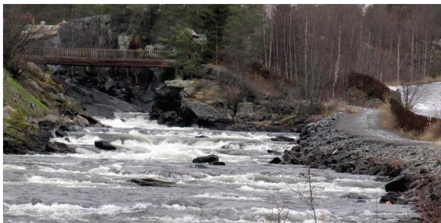
Figur 6.1: Elven er steinsatt på begge sider ved utløpsområdet og oppover langs turveien langs elva. Foto: Ahmed R. Naserzadeh , NVE.
