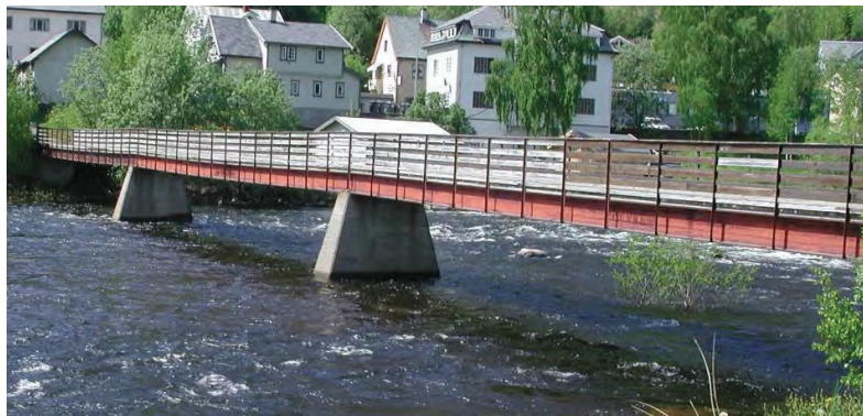
Figur 3.5: Gangbru ved profil 2.
