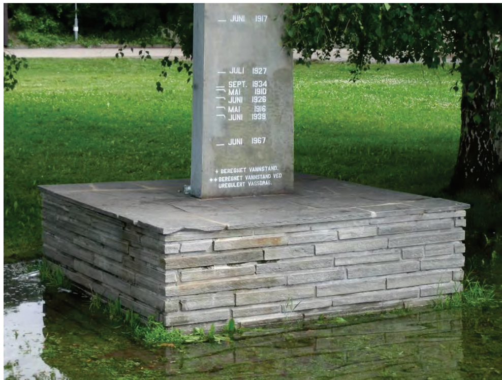
Figur 2.6: Flomstøtta i Fagernes 8. juli 2007, med vannstand 356,18 moh i Strondafjorden. Foto: FBR.
