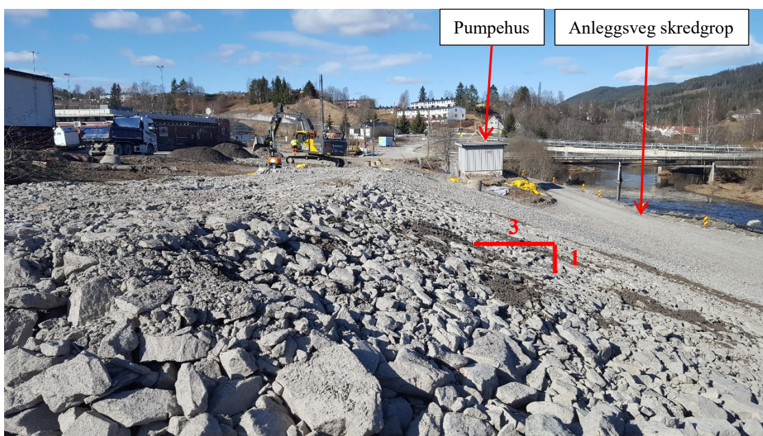
Figur 2 viser støttefylling med helning 1:3 den 19.03.2020, sett fra sør mot nord. Fyllingen består av sprengstein. Etter at dette bildet ble tatt, er det lagt ut fiberduk og et tynt jordlag på toppen av fyllingen. Bildet er tatt av Nittedal kommune
