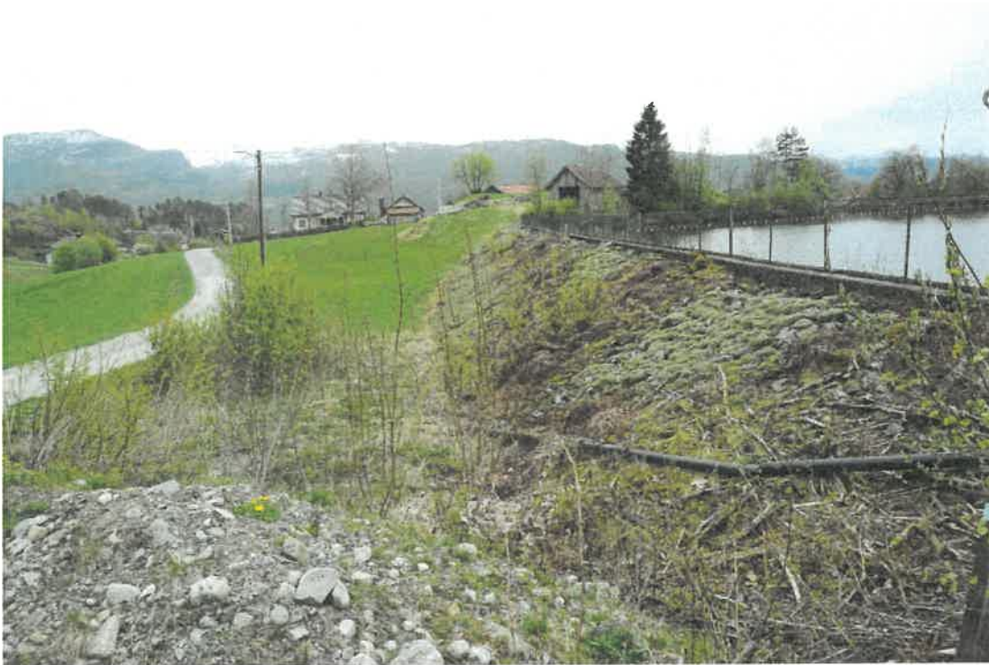
Bilde 2 Fyllingsdammens luftside har stein i overflaten.
