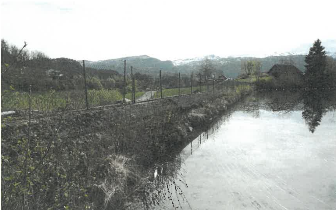
Bilde 3 Fyllingsdam vannside. Det er en betongkant med gjerde på toppen.
