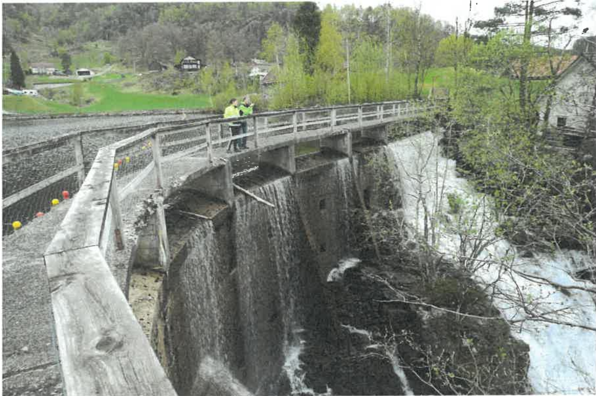
Bilde 1 Betongdam luftside. Det er buedam i midten med tilslutninger som platedam. Rekkverk i tre.
