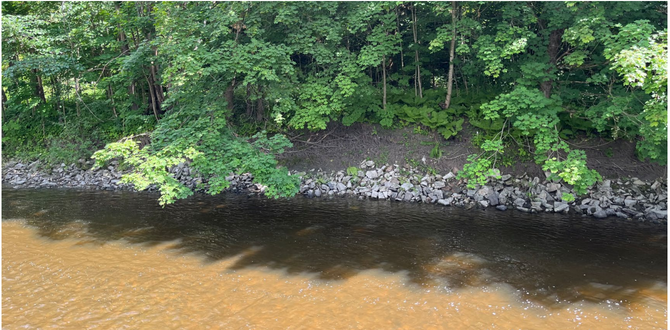
Figur 3.9 Erosjonssikring nedstrøms yttersvingen ved Ila gård.
