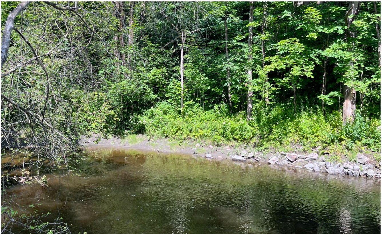
Figur 3.10 Manglende erosjonssikring i yttersvingen ved Ila gård.
