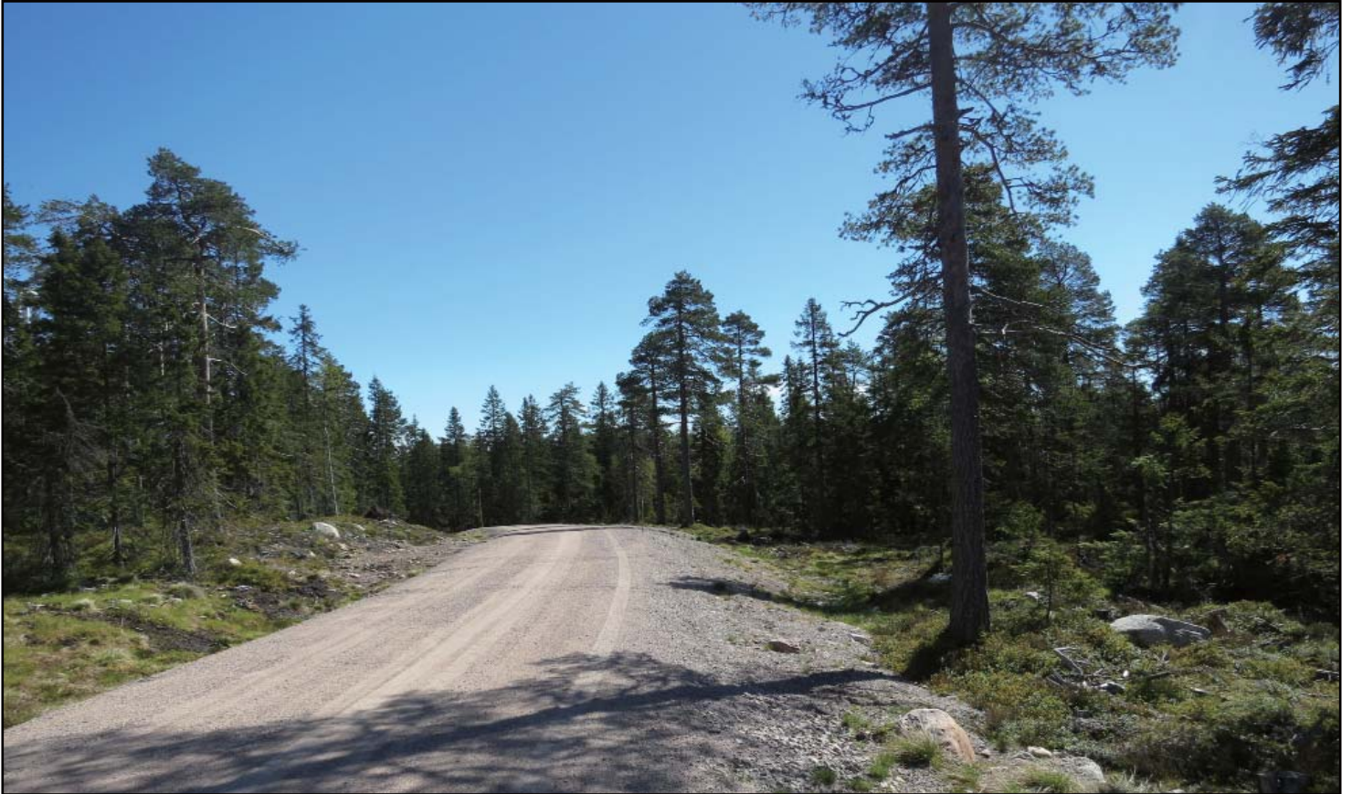
For å myke opp sideprofilen settes det igjen noen enkelttrær eller tregrupper nær veilinjene. Disse merkes tydelig før arbeidene starter.
