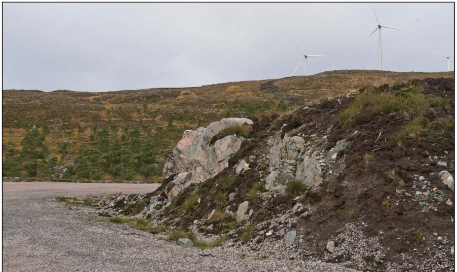
Jordmasser er trukket ned fra toppen og inn i foten av skråningen, og gir fjellskjæringen bedre landskapstilpasning og visuell forankring.
