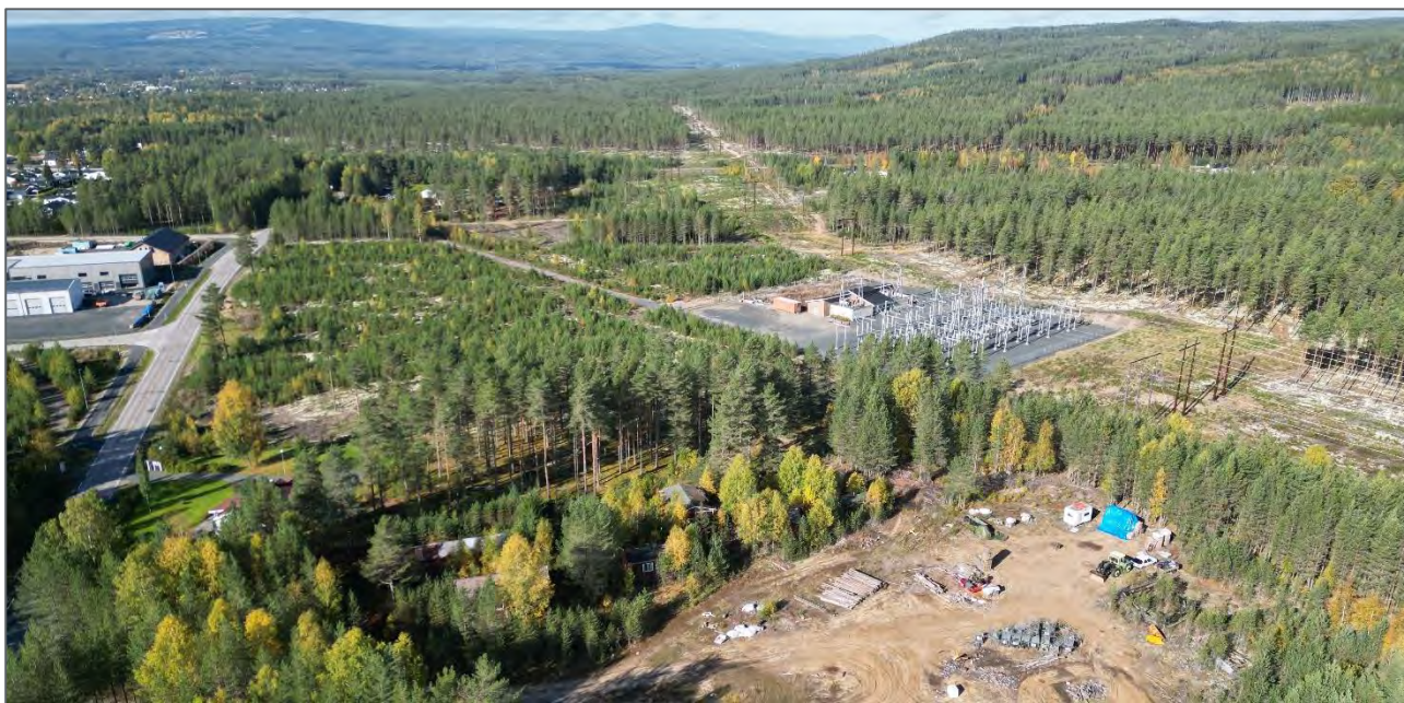
Figur 5-17: Dronebilde tatt mot vest i delområdet, hvor transformatorstasjon og lagerområde er lokalisert.
