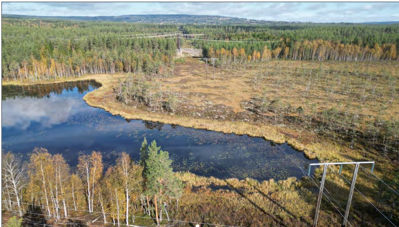
Figur 5-18: Dronebilde fra østre del av Posttjennsmyra med kryssende kraftledninger.
