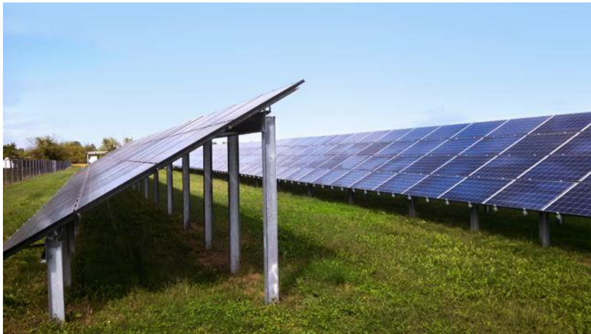
Figur 3-3 Fast-vinkel installasjonsløsning (foto: Willowbrook Solar).
