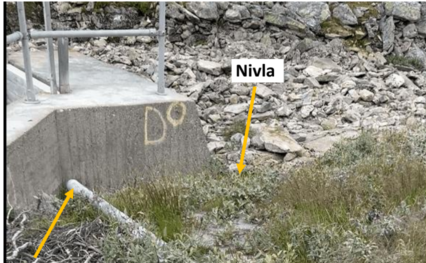
Forbikoplingen fra nedløpsrøret til Nivla ved bekkeinntaket
