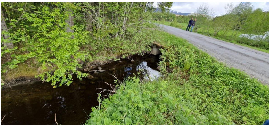
Bilde 4 - Bilde tatt mot kulvert som går under Utnesveien. Kulvertens har mål B x H = 0,6 m x 0,9 m
