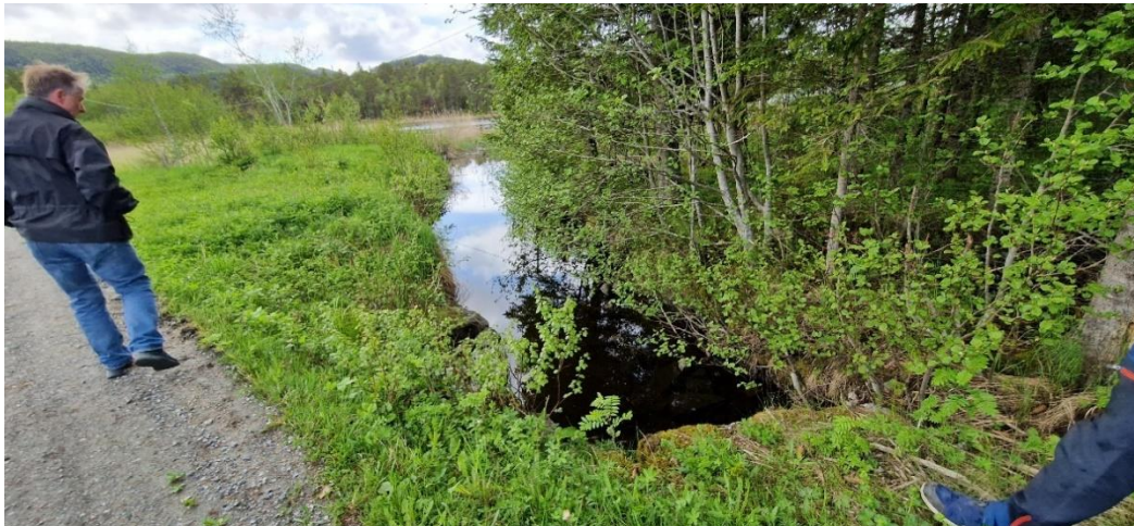
Bilde 2 - Bilde tatt fra Utnesveien mot Fiskløysa. Bjelkestengsel er tenkt plassert ca. 3-4 m oppstrøms kulvert under veg
