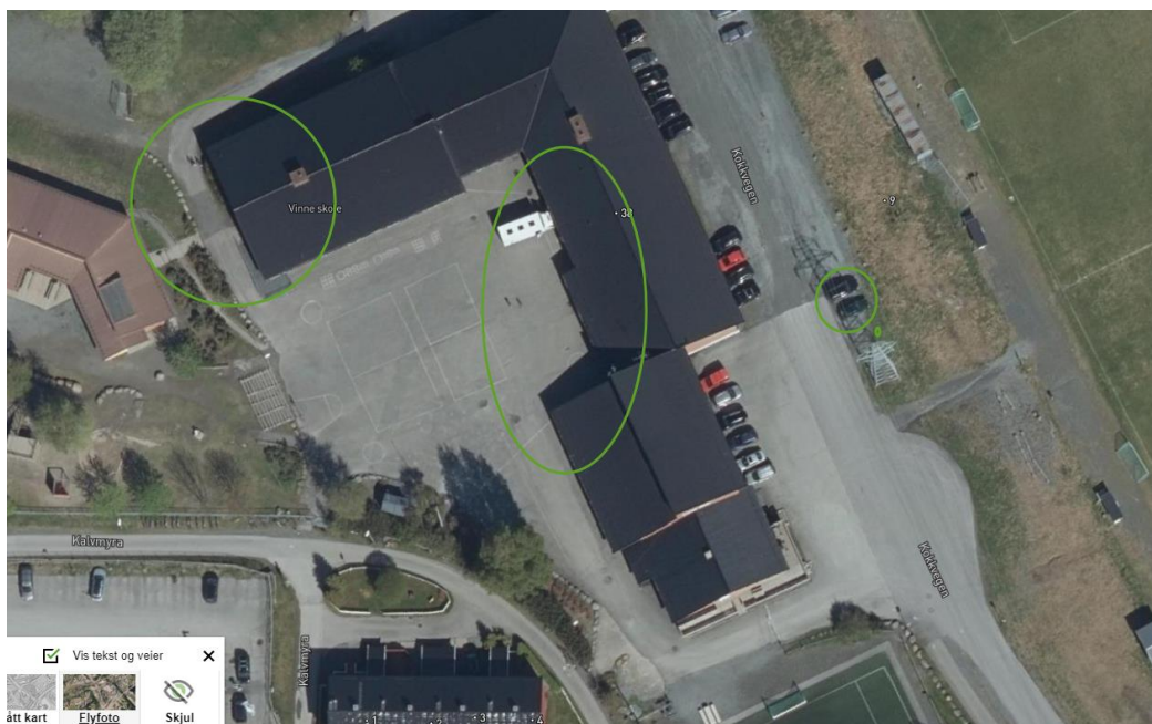
Figur 9 viser lokasjoner der det ble sprengt i forbindelse med etablering av Vinne skole
