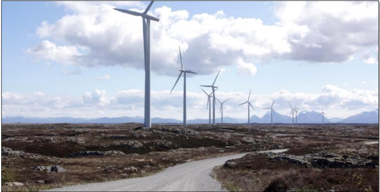
Figur 2-4. Smøla vindkraftverk med internveger og vindturbiner. Vegene i et vindkraftverk har normalt en bredde på ca. 5-6 m og grusdekke.
