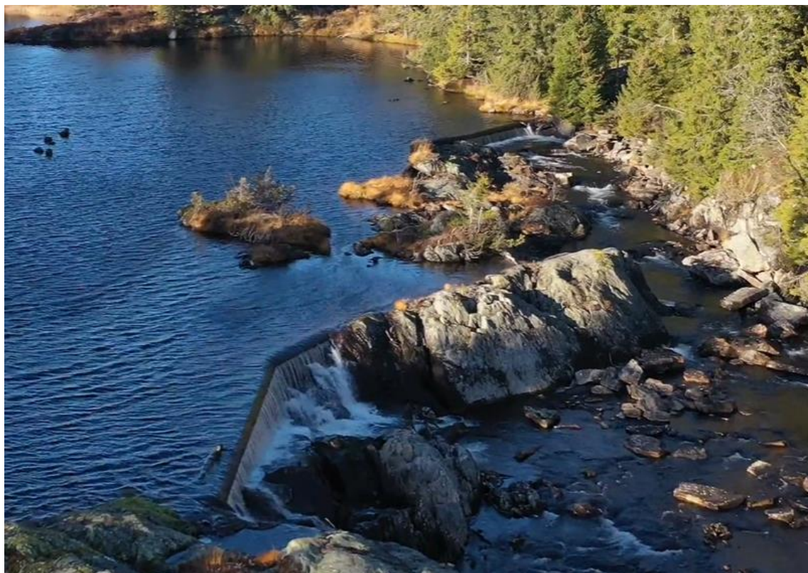
Figur 9. Eksempel på terskel fra øvre del av Sæbyggjeåi som er anlagt uten tanke på å ivareta muligheter for fiskevandring.
