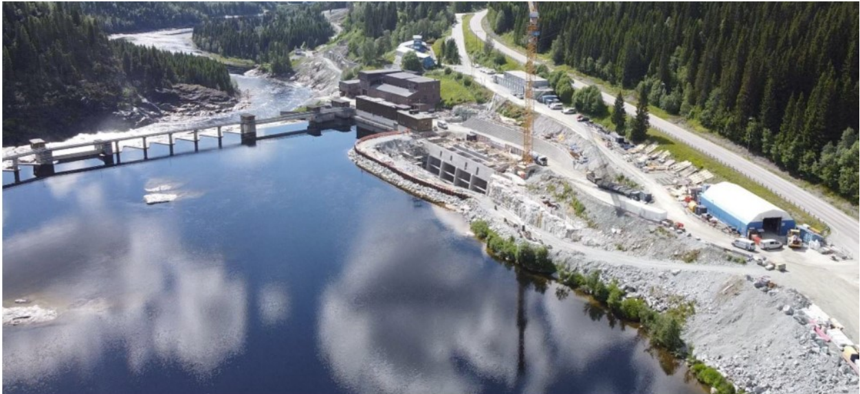
Bilde 1: Utbyggingsområde med fangdam og nytt inntak ca. 50 meter oppstrøms dam til høyre for eksisterende kraftverk.
