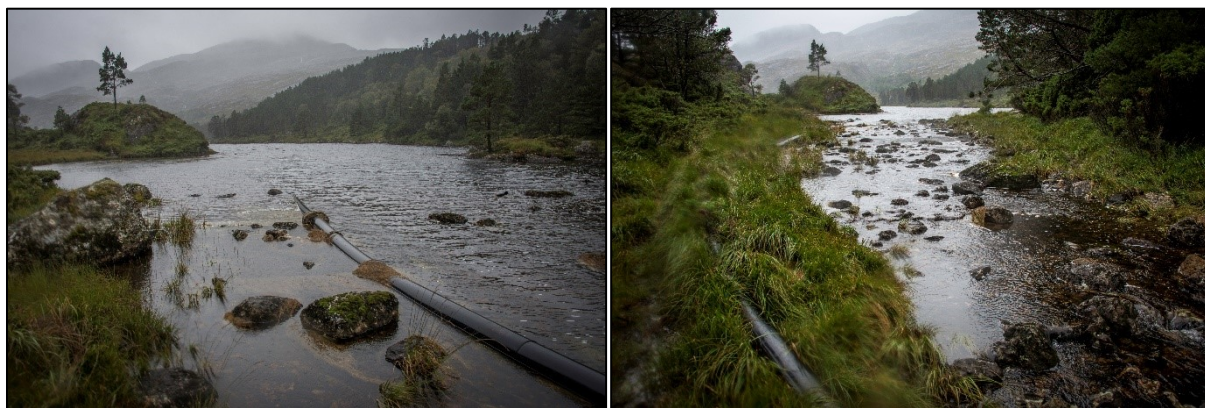
Figur 4. Vanninntak i Skogevatnet ( venstre ). Vannet ledes gjennom et 1000 m langt rør på 200 mm ned til anlegget. Den øvre delen av utløpselven med gyteområder for ørret ( høyre ).
