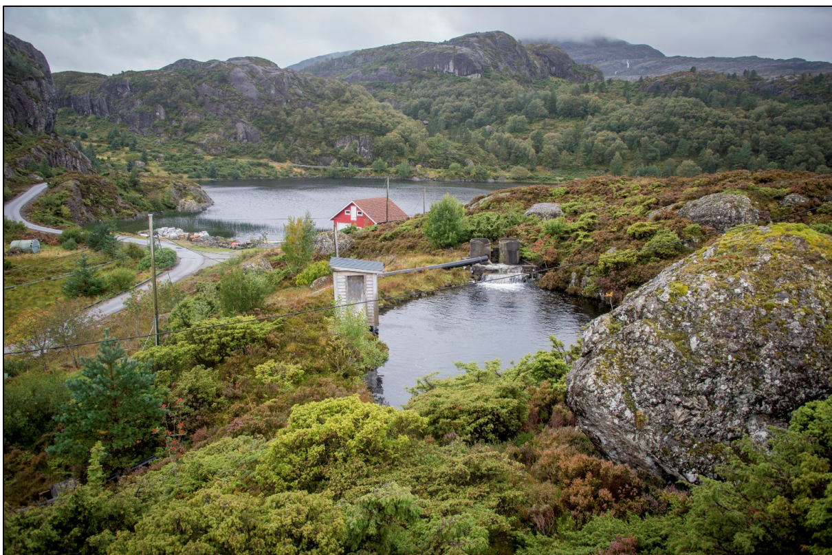
Figur 5. Høydebassenget er 230 m 2 stort og ligger 11,5 moh. Med en antatt gjennomsnittsdypde på 2 m, gir det et volum på nærmere 500 m 3 .
