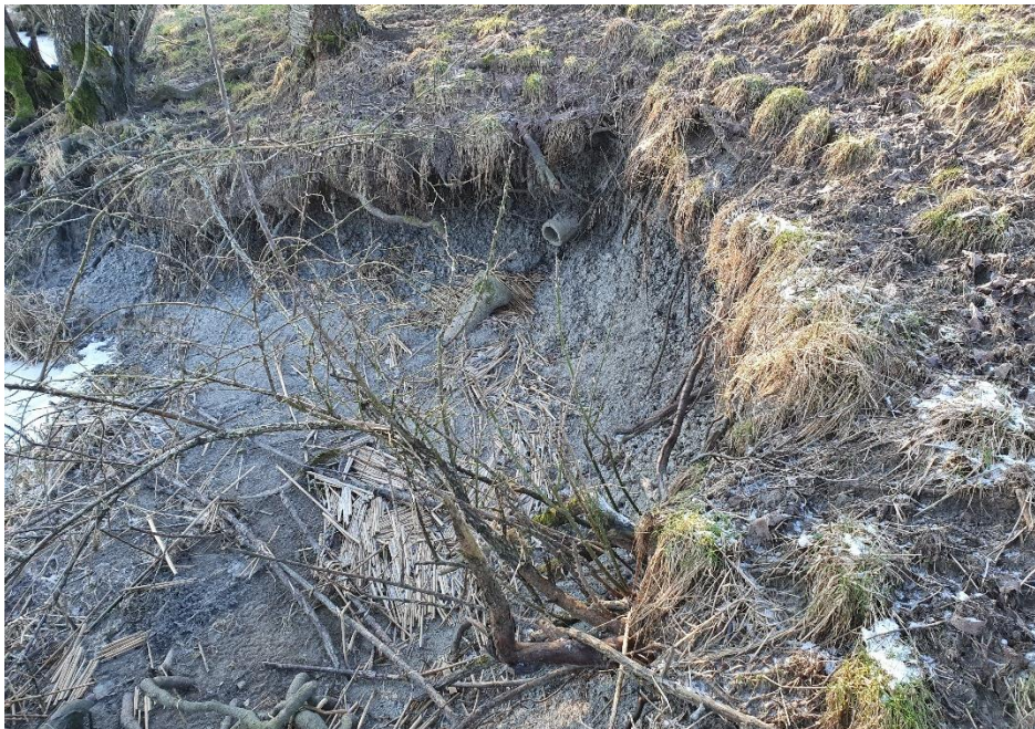
Figur 4-12: Eksempel på erosjon pga. jordbruksdrenering, se referanseområde 3 på Figur 4-9.
