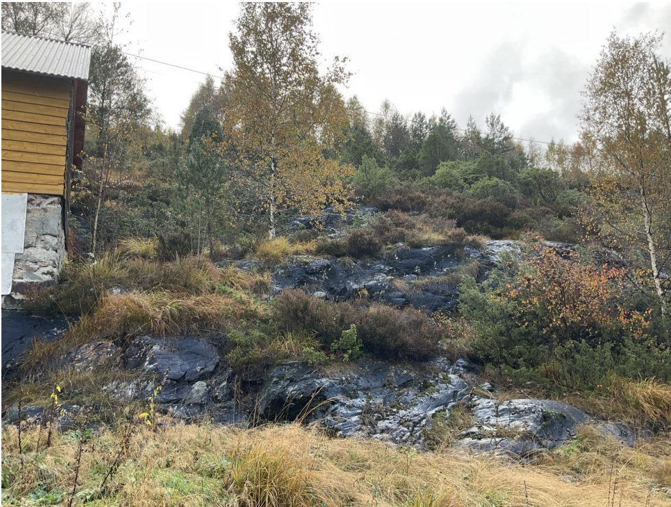
Bilde 11. Bergskrent vest for kartleggingsområdet. Noe oppsprekking, men lav løsnepotensiale for steinsprang.
