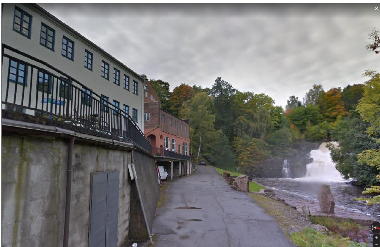
Figur 19. Gamle industribygninger fra 1800-1900 tallet nedenfor Fåbrofossen. I den røde leirsteinsbygningen er i dag Fossekallen restaurant og konferansesenter.
