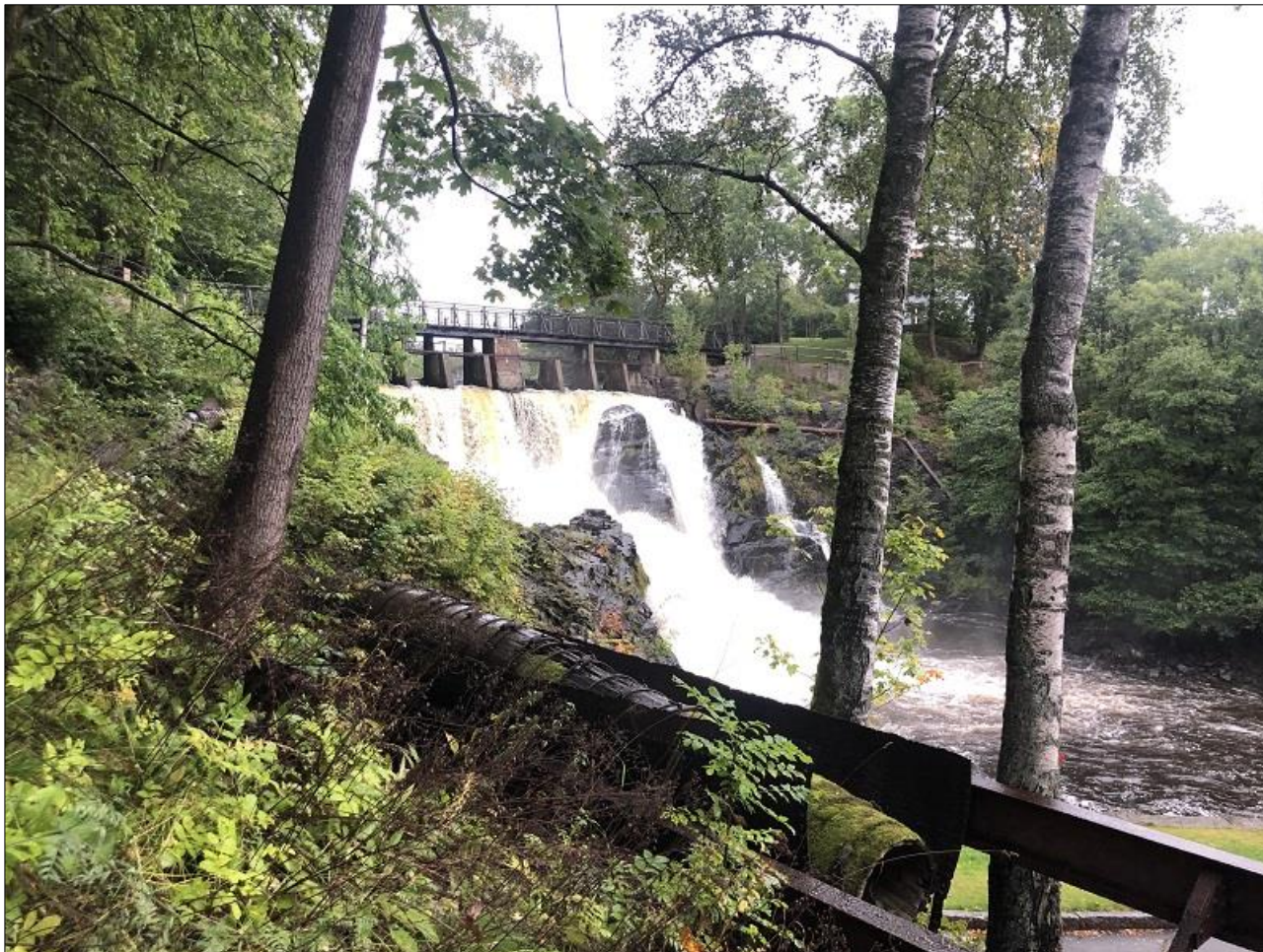
Figur 3. Fåbrofossen med et gammelt tilløpsrør i forgrunnen og et mindre rør på den andre siden av elva. Bilde: Norconsult.
