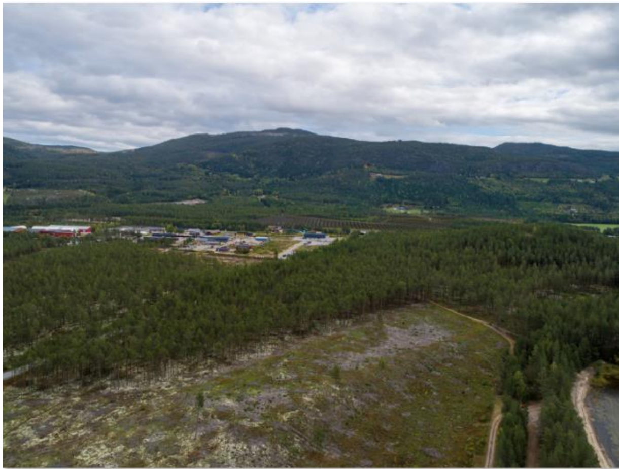
Figur 16: Visualisering av Fyresdal solkraftverk sett fra Birtedalsveien på vestsiden av solkraftverket 113 meter over bakken.
