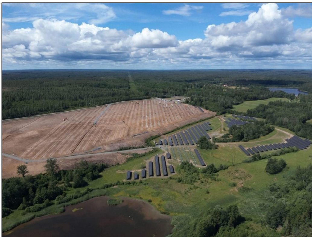
Figur 9: Mörghult solkraftverk (14,1MWp) er ett av Solgrid sine prosjekter under bygging. Til venstre er prosjektet i anleggsfasen, mens til høyre er anlegget ferdig montert.
