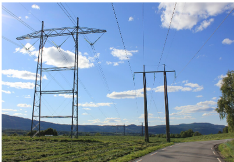
Figur 14: 420 kV sentralnettslinje og 132 kV regionalnettslinje i parallell.
