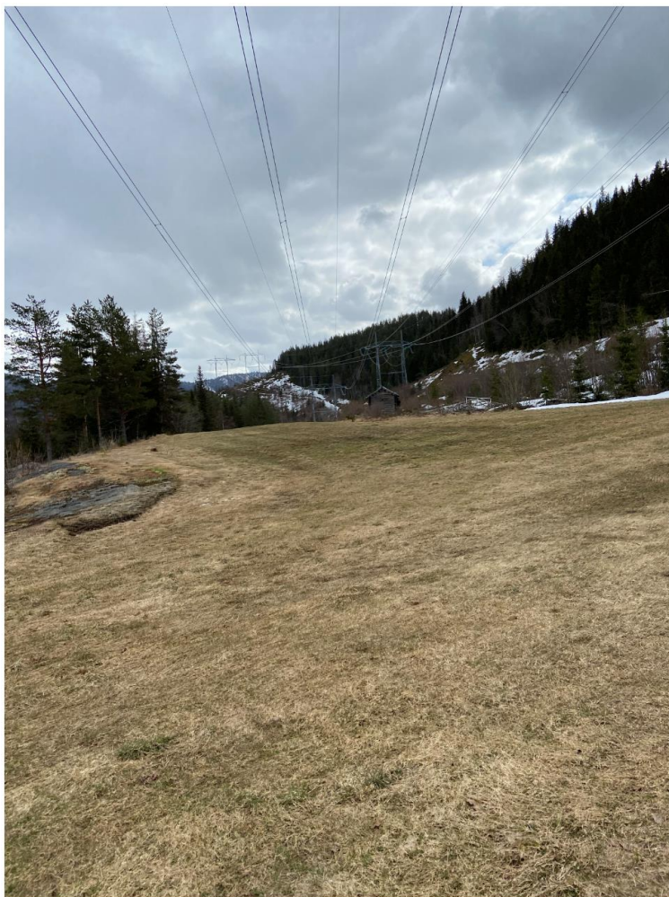
Figur 5 Dagens 420 kV ledninger, sett fra mastepunkt A-10
