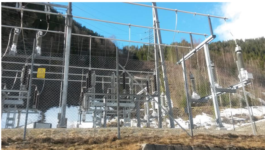
Figur 3 Bestykket reservefelt i Nore 2, med eksisterende ledning (dobbel kurs) mot Flesaker i bakgrunn
