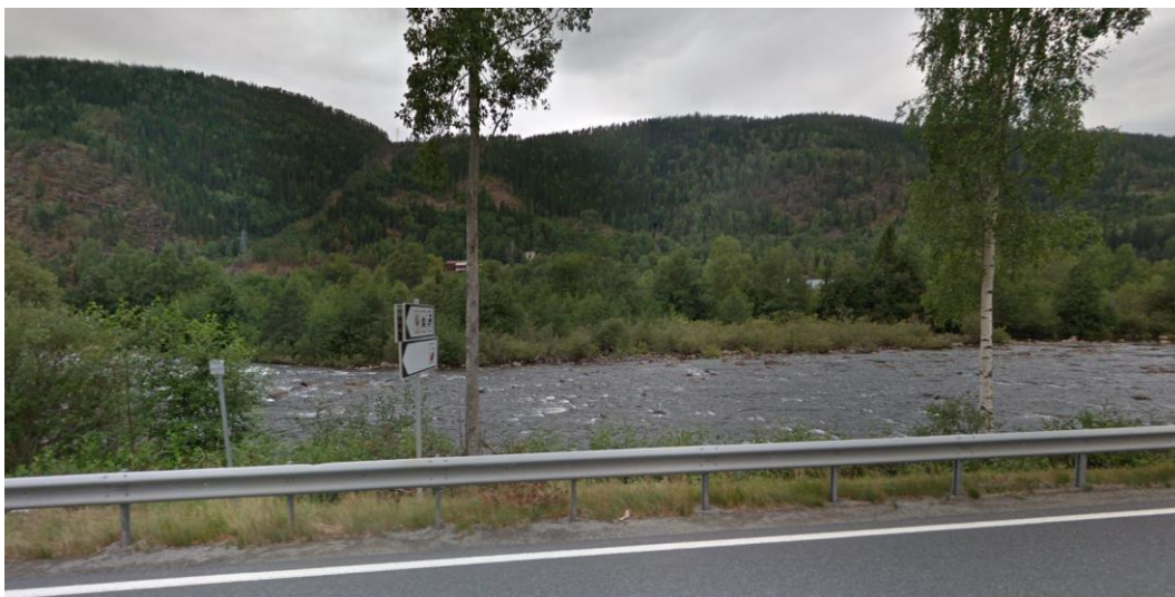
Figur 13 Glitres 132 kV luftledning og båndlagt areal (ryddebelte) er synlig fra Fv. 40 øst for Numedalslågen og Nore II kraftverk. Kilde: Google Maps.
