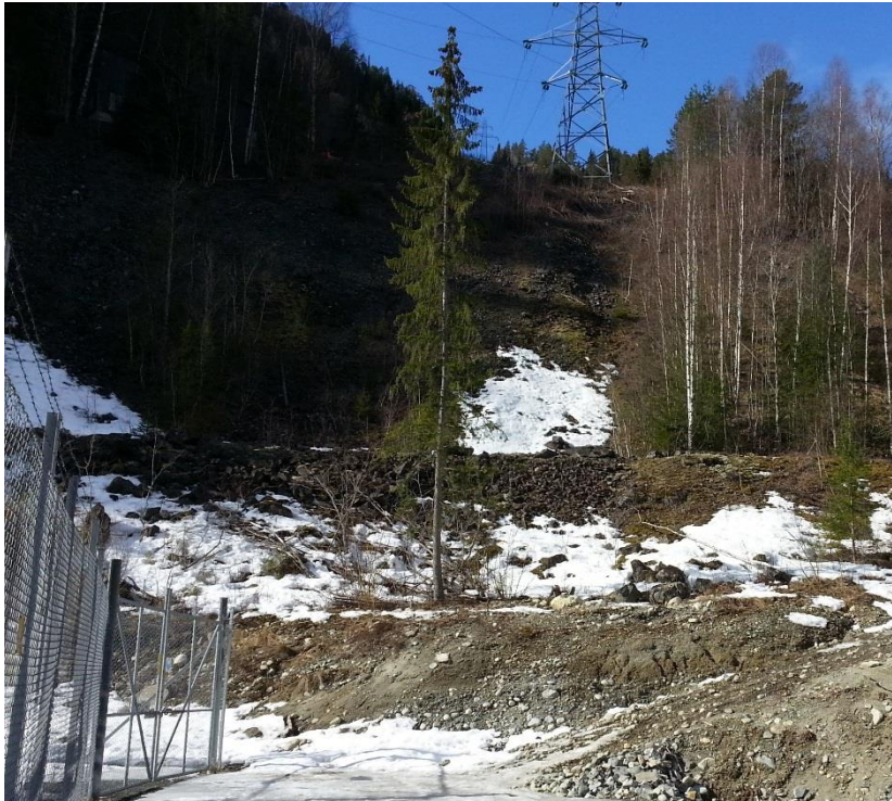
Figur 4 Første mast for luftledninger til Flesaker ut av Nore 2
