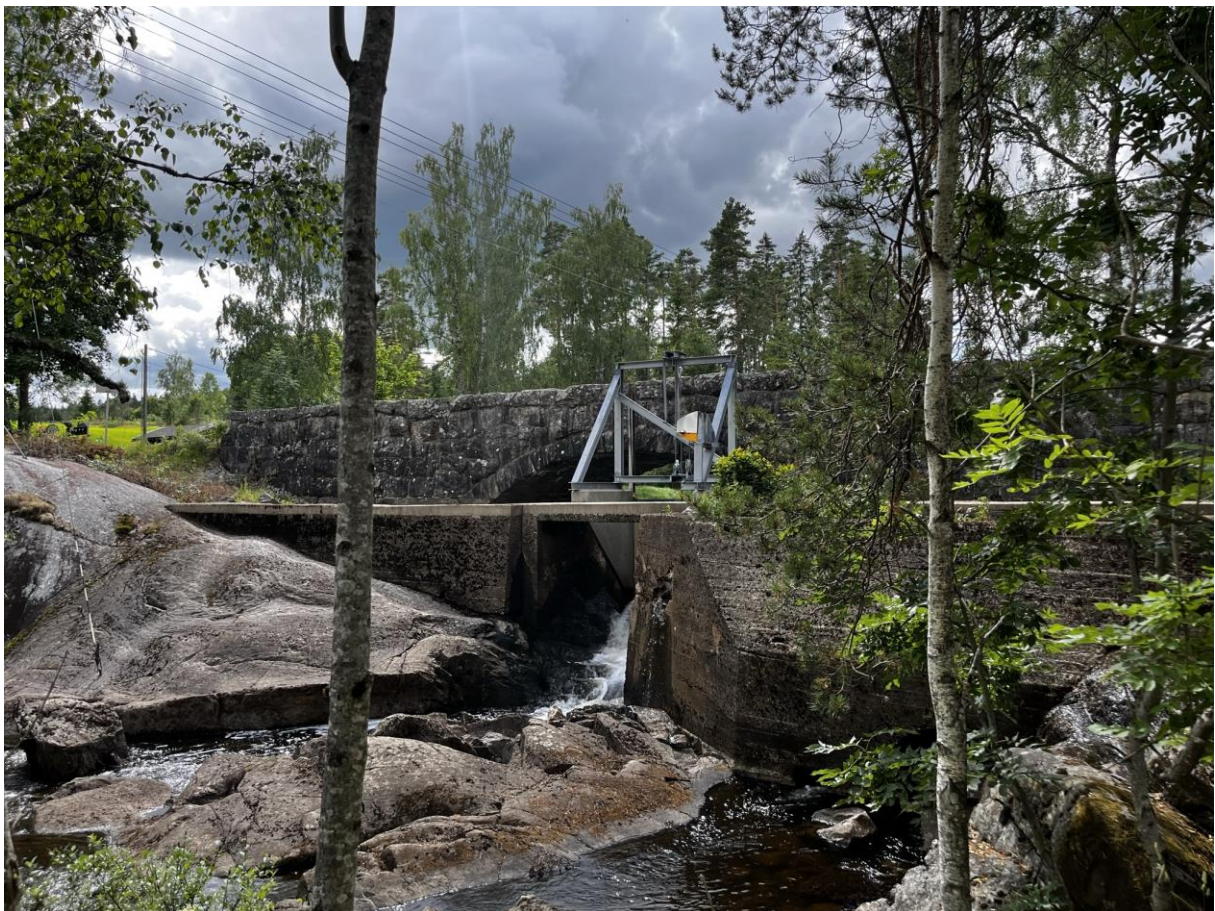
Figur 3. Dammen ved Våg sett fra sør, der påstøp av ny damkrone ses ved det hvite feltet øverst på dammen. Glideluken er montert oppå damkronen og justeres manuelt ved behov. I bakgrunnen ses steinbroen Vestby bru.
